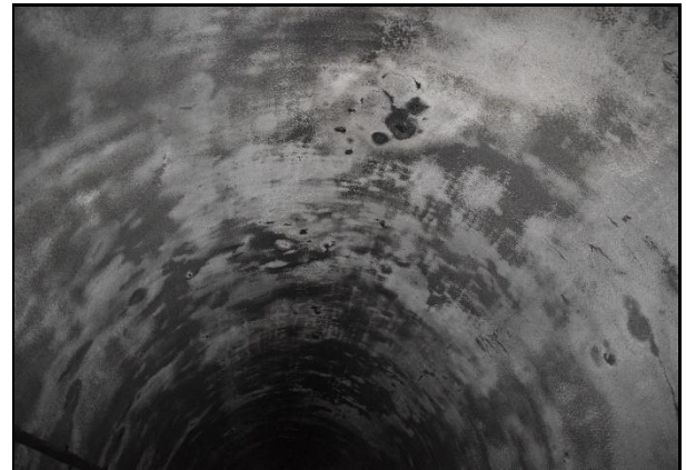
Figura 21 e 22. Calotta con limitati ammaloramenti e armatura localmente esposta
