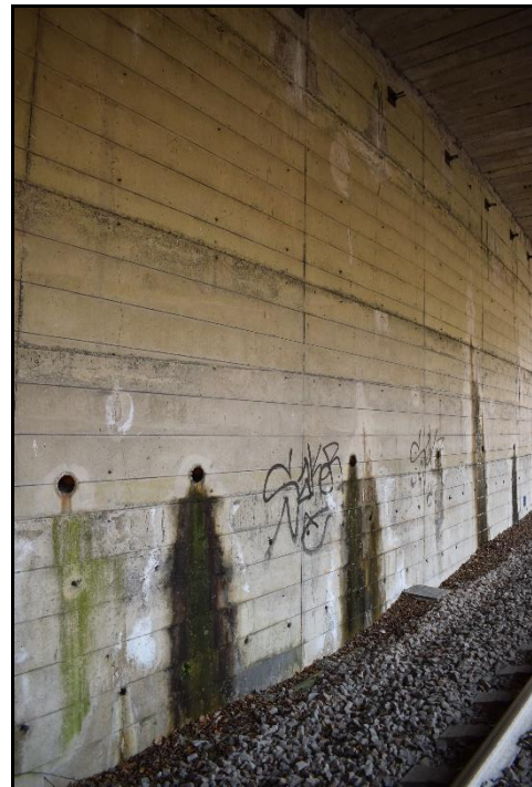
Figura 23 e 24. Parete contro-roccia della galleria artificiale con percolazioni dai giunti e dai drenaggi
