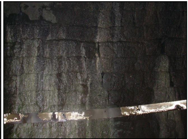
Figura 3 e 4. Stato dei piedritti con percolazioni, stillicidi e incrostazioni.
