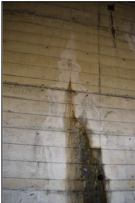
Figura 23 e 24. Parete contro-roccia della galleria artificiale con percolazioni dai giunti e dai drenaggi
