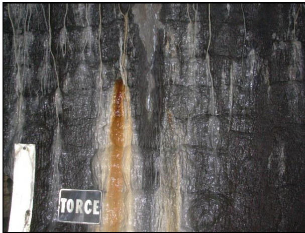
Figura 3 e 4. Stato dei piedritti con percolazioni, stillicidi e incrostazioni.
