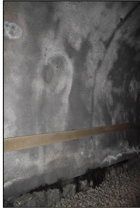
Figura 19 e 20. Piedritti con limitati ammaloramenti
