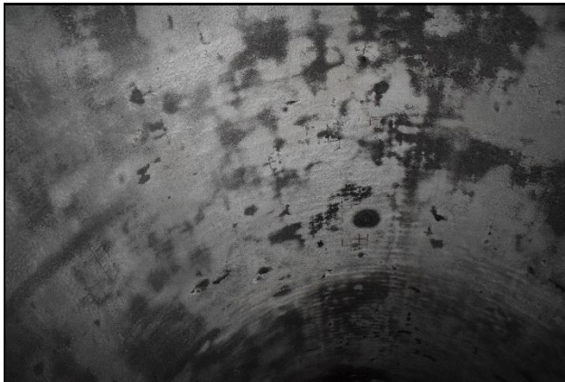
Figura 21 e 22. Calotta con limitati ammaloramenti e armatura localmente esposta
