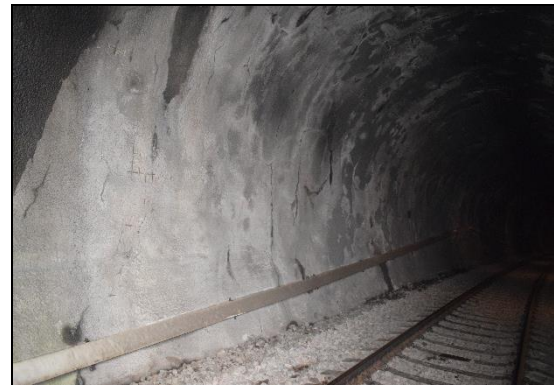
Figura 13 e 14. Tratto della lunghezza di 7 metri circa senza rivestimento e leggera esposizione dell'armatura della gunite sul piedritto
