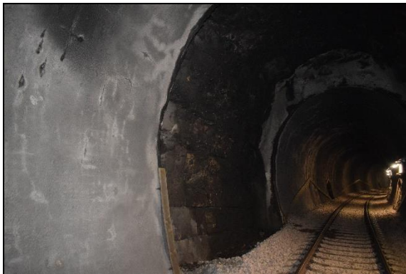
Figura 13 e 14. Tratto della lunghezza di 7 metri circa senza rivestimento e leggera esposizione dell'armatura della gunite sul piedritto
