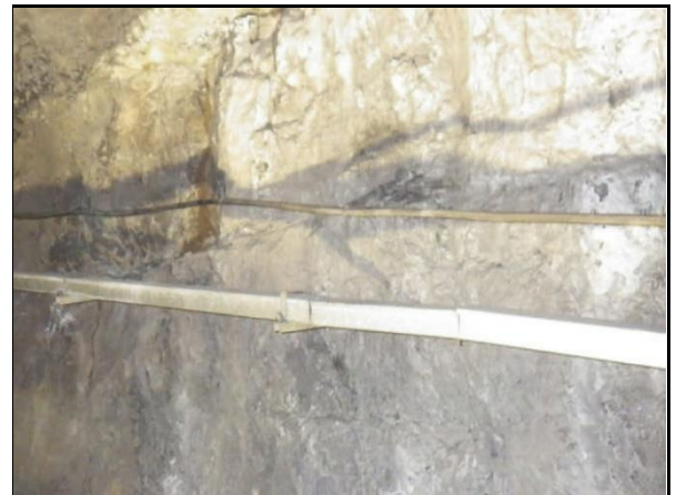
Figure 9 e 10. Breve tratto senza la presenza di gunite e la roccia in posto all'interno della tratta
