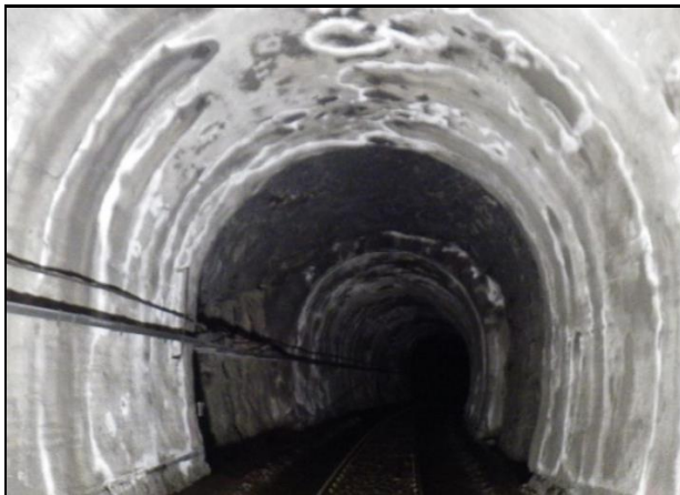
Figure 9 e 10. Breve tratto senza la presenza di gunite e la roccia in posto all'interno della tratta
