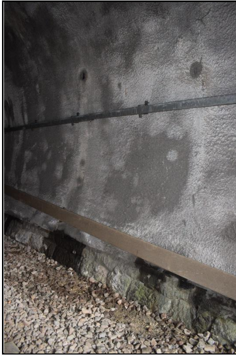
Figura 19 e 20. Piedritti con limitati ammaloramenti
