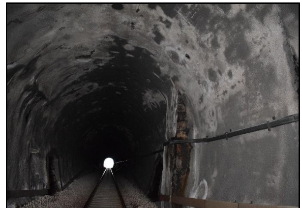
Figura 17 e 18. Stillicidi nella tratta non rivestita; limitati ammaloramenti nella tratta con spritz/gunite e localizzato cambio di sezione
