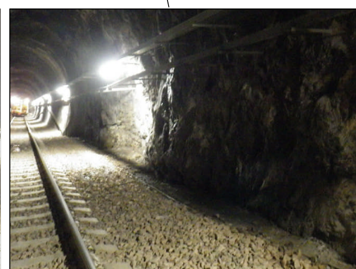
Tratto non rivestito
