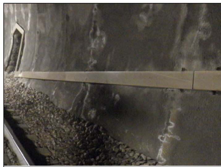
Rivestimento in spritz beton/gunite con umidità
