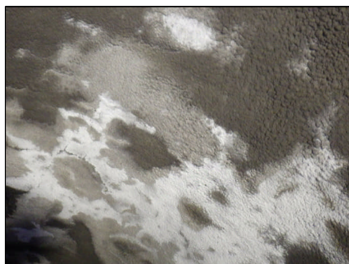
Rivestimento in spritz beton/gunite con umidità
