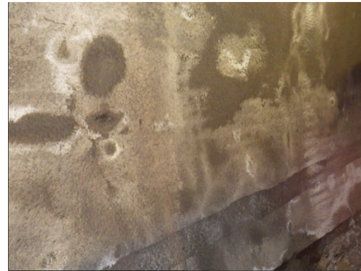
Rivestimento in spritz beton/gunite con umidità
