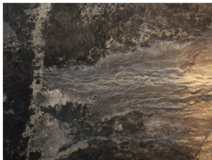
Tratto non rivestito
