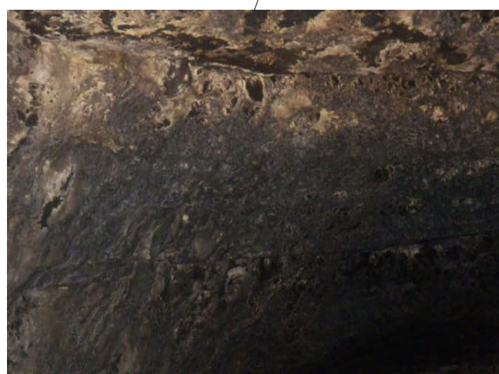
Tratto non rivestito
