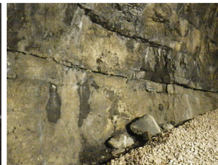
Tratto non rivestito
