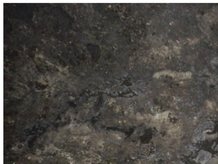
Tratto non rivestito
