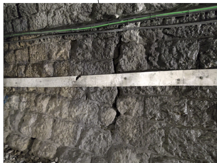
Rivestimento in bognini con lesione
