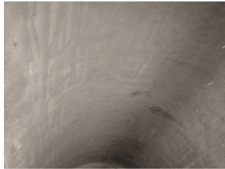
Rivestimento in spritz beton/gunitite
