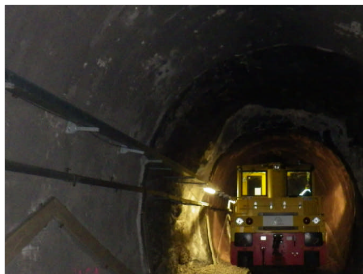
Passaggio tra rivestimento in rivestimento in spritz beton/gunite e roccia naturale
