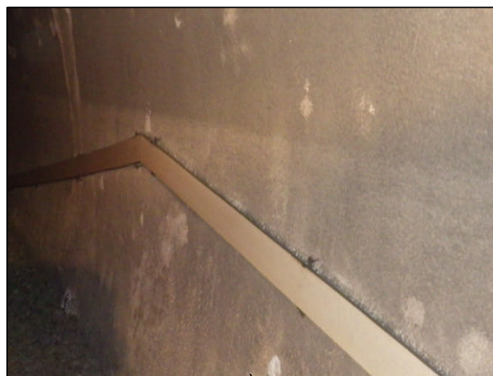
Rivestimento in spritz beton/gunite sul piedritto
