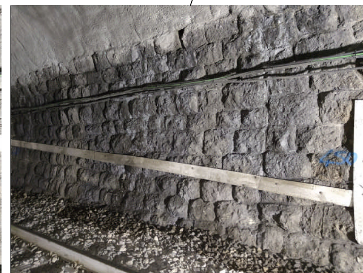
Rivestimento in bognini con venute d'acqua
