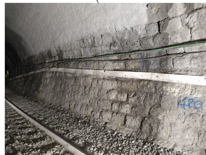
Rivestimento in bognini con venute d'acqua
