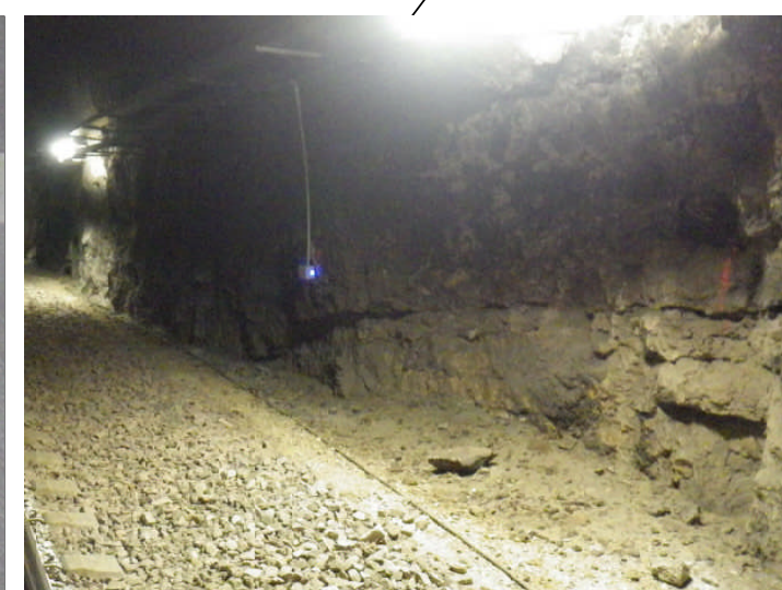
Tratto non rivestito
