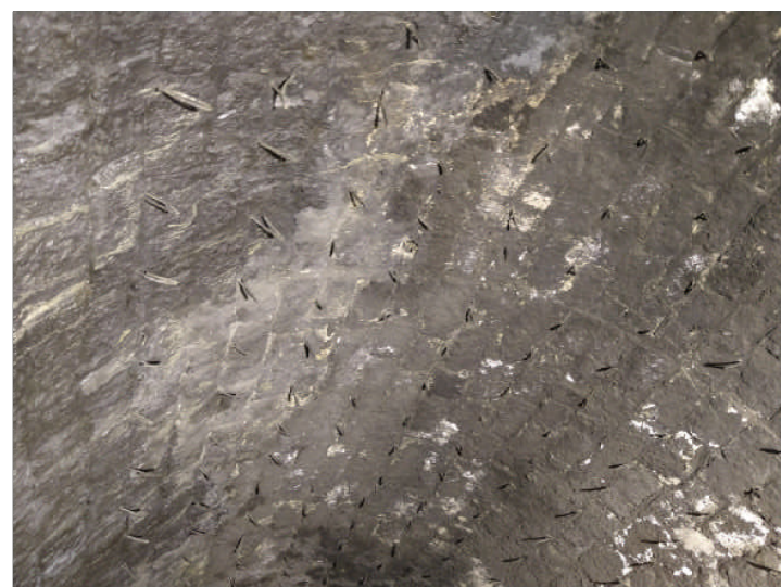
Rivestimento in bognini con con iniezione di resine
