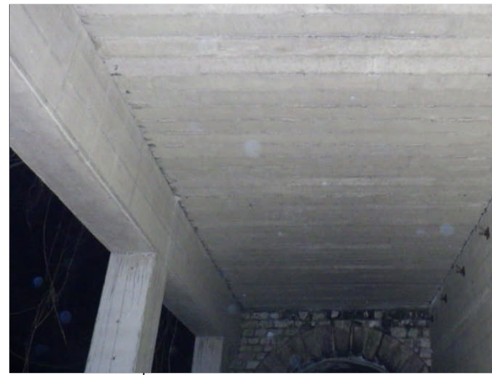
Galleria artificiale in calcestruzzo armato
