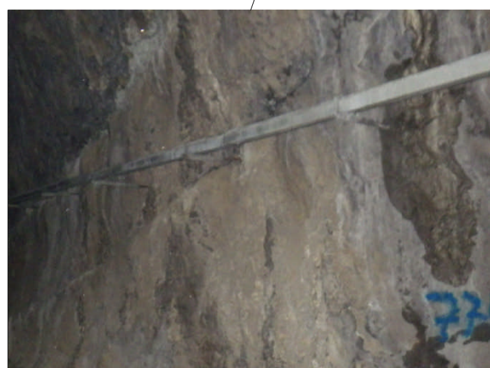
Tratto non rivestito
