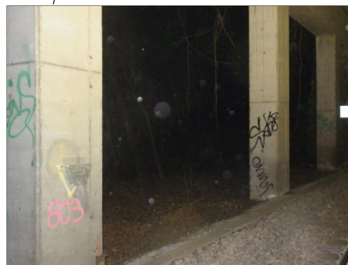
Galleria artificiale in calcestruzzo armato
