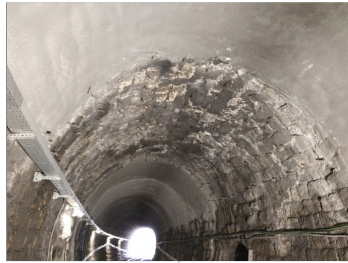
Passaggio tra rivestimento in spritz beton/gunita e rivestimento in bognini con iniezione di resine ed umidità
