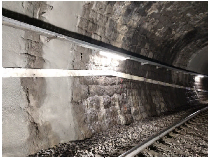
Ripristino in calcestruzzo su piedritto
