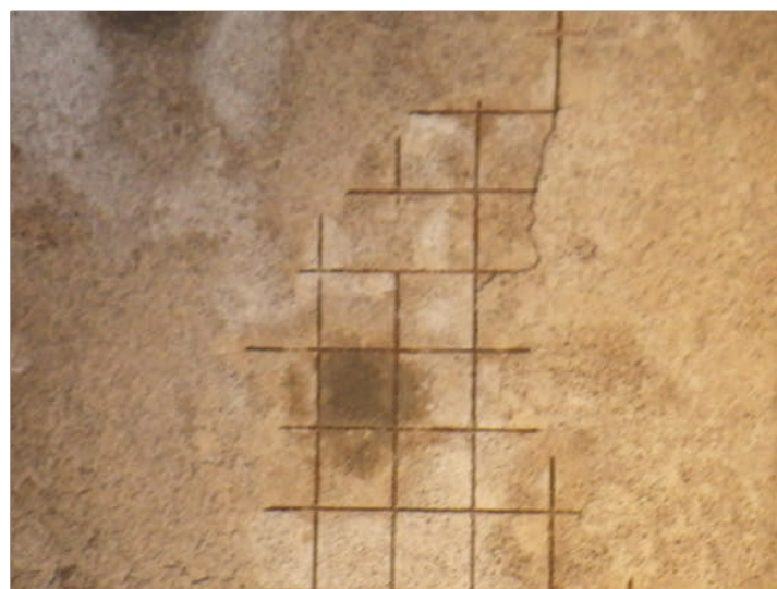
Rivestimento in spritz beton/gunite con armatura esposta
