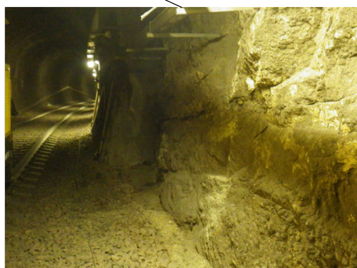
Tratto non rivestito
