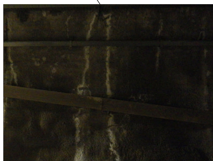
Rivestimento in spritz beton/gunite con umidità
