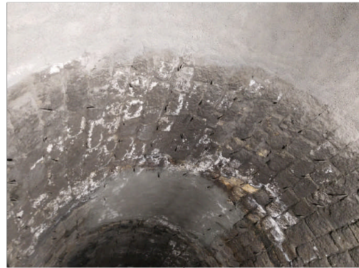
Rivestimento in bognini con umidità e ripristino in calcestruzzo
