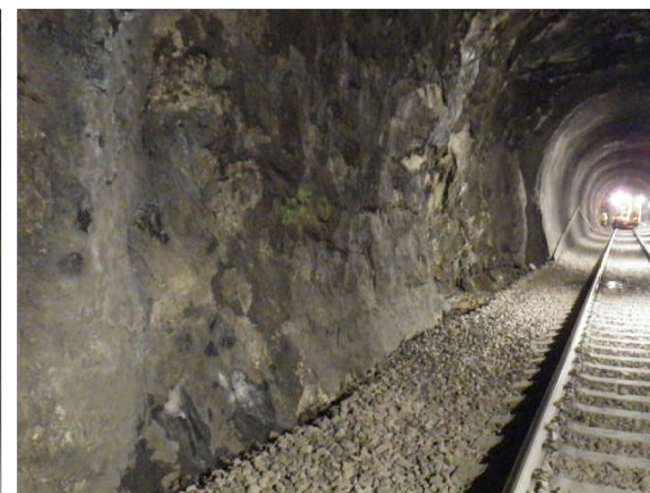
Tratto non rivestito
