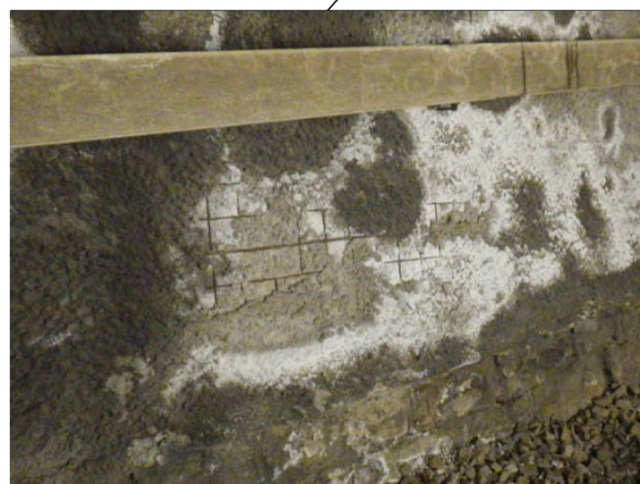
Rivestimento in spritz beton/gunite con armatura esposta
