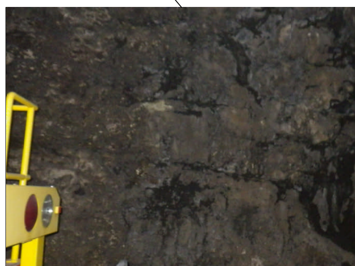
Tratto non rivestito
