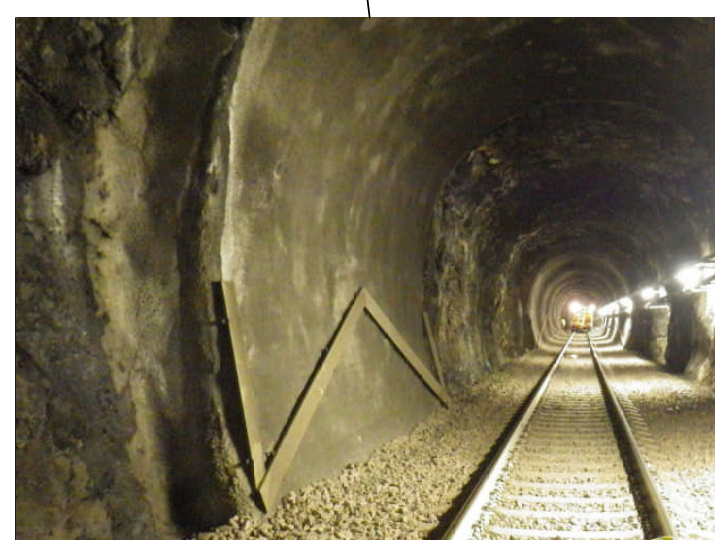
Passaggio tra rivestimento in spritz beton/gunite e roccia naturale
