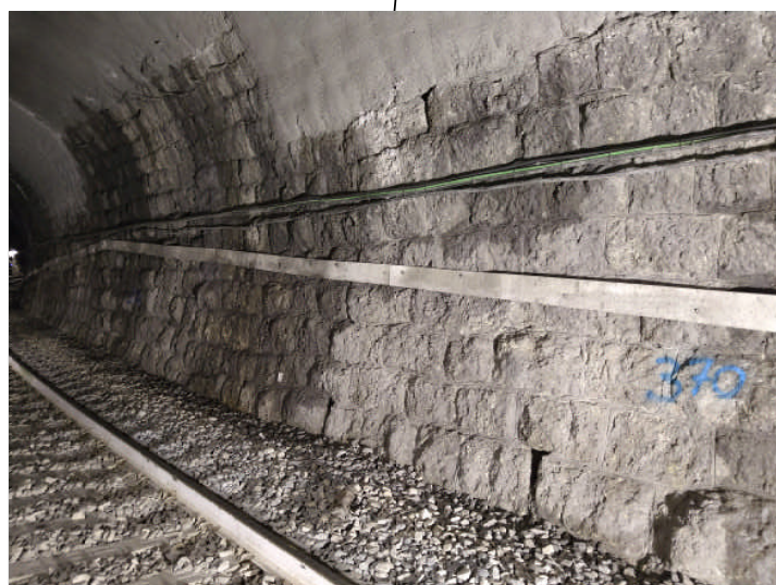
Ripristino in calcestruzzo con venute d'acqua
