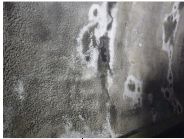
Rivestimento in spritz beton/gunite con umidità
