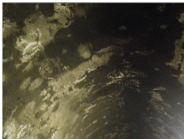
Rivestimento in spritz beton/gunite con umidità
