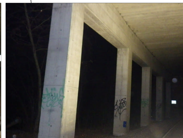
Galleria artificiale in calcestruzzo armato
