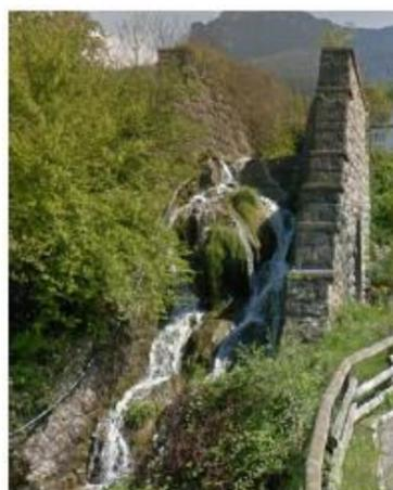
L'ingresso del canale avviene sul lato di monte della scarpata che degrada sullo scivolo, consentendo il collegamento del canale con il reticolo idrografico esistente.
