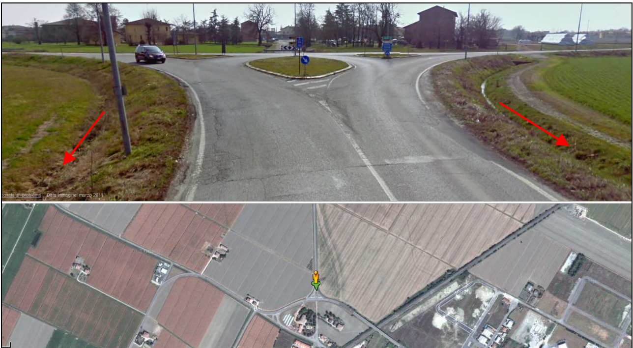
Figura 4.1 – Immagine della strada alla stato attuale con i fossi a bordo strada.
