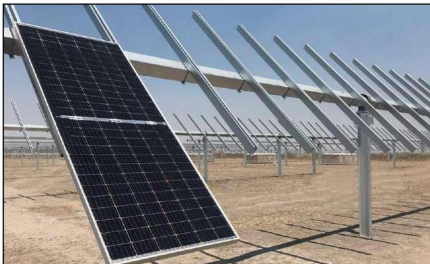
Figura 5 – esempio di tracker fotovoltaico
