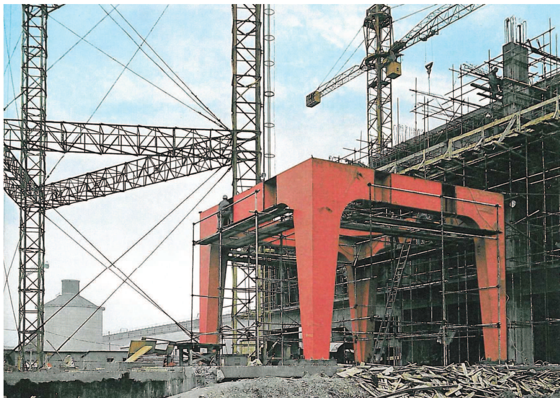
Figura 3-2 La costruzione della centrale termoelettrica (foto: 1963)
