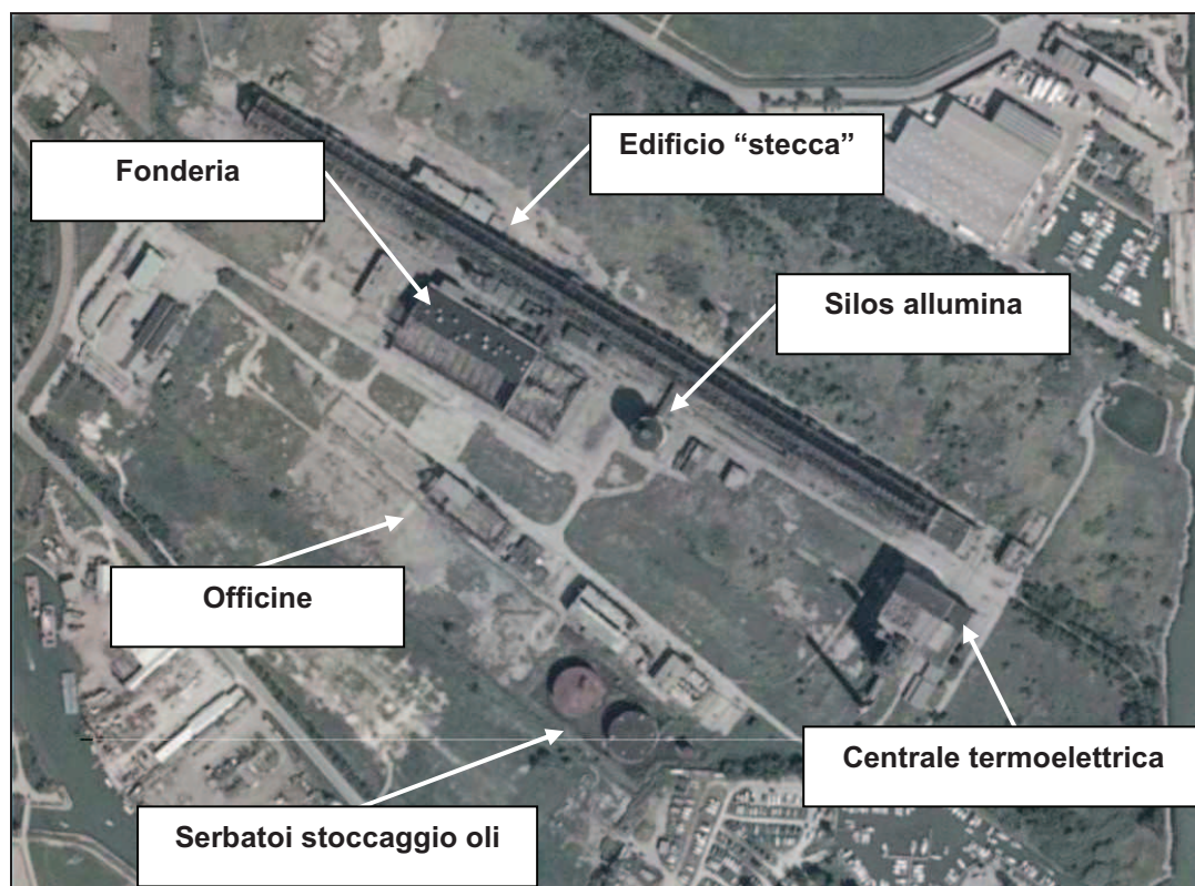
Figura 3-3 Edifici esistenti (fotovolo 2006)
