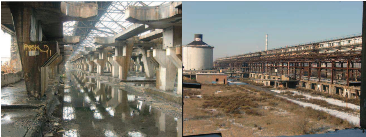
Figura 2-4 Edificio "stecca", particolare interno ed esterno (con silos allumina)
