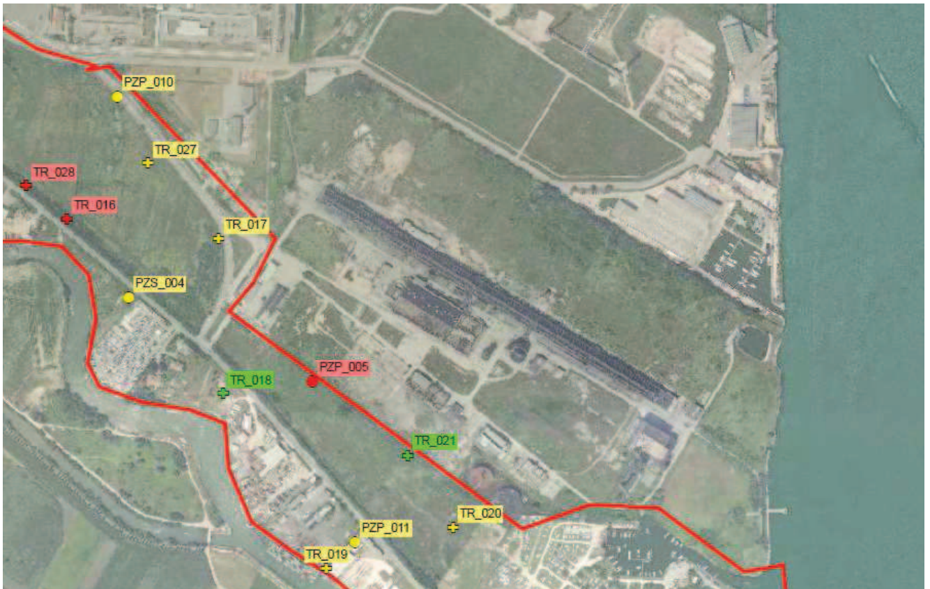
Figura 4-7 – Indagini ARPAV 2010 adiacenti il sito ex Alumix (terreni)
