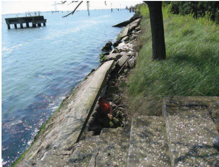
Figura 2-8 Tratto di sponda rivestito in pietrame ammorsato in cls
