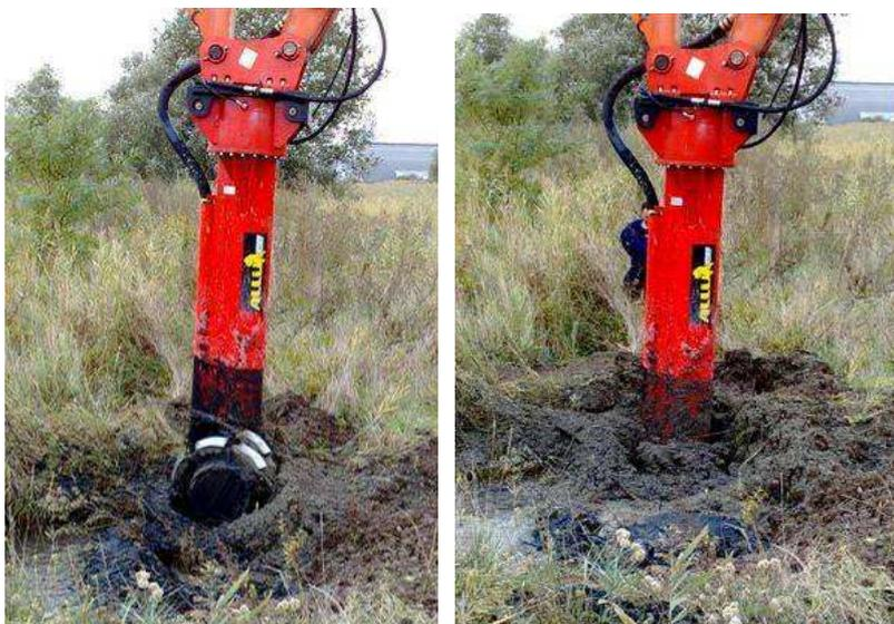
*Figura 6-1 - La fresa per il previsto trattamento in situ; durante il maneggio del terreno vengono iniettati i leganti (calce e/o cemento) con sistema pneumatico*
