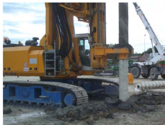
Figura 4-4 – utensile per la realizzazione di pali FDP e fase operativa
