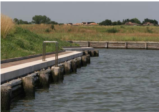
Figura 5.1-2 A sinistra vista della pannellature in legno nel tratto di sbocco in laguna del canale alle Rotte, fra la penisola di S. Giuliano e la barena di Campalto; a destra un particolare della connessione al cordolo.
