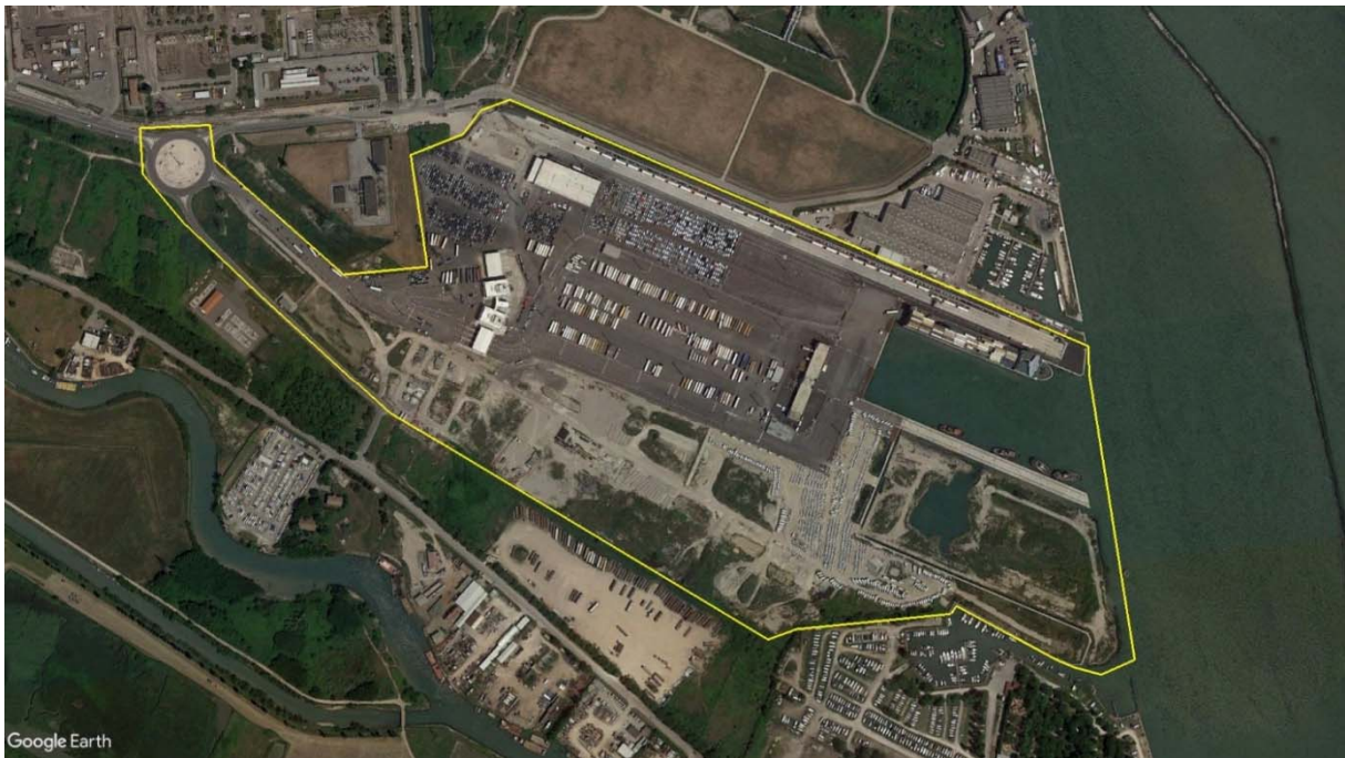
Figura 8-1 – Stato dei luoghi al termine della validità del parere VIA – fonte Google Earth – 05/2017
