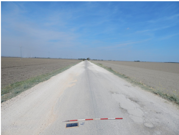
DSCN_5834 (UR 9 - Cavidotto km 7.00 - 8.00)
