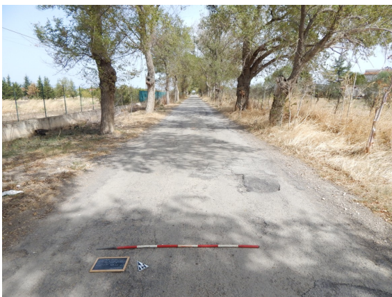
DSCN_5824 (UR 3 - Cavidotto km 1.00 - 2.00)
