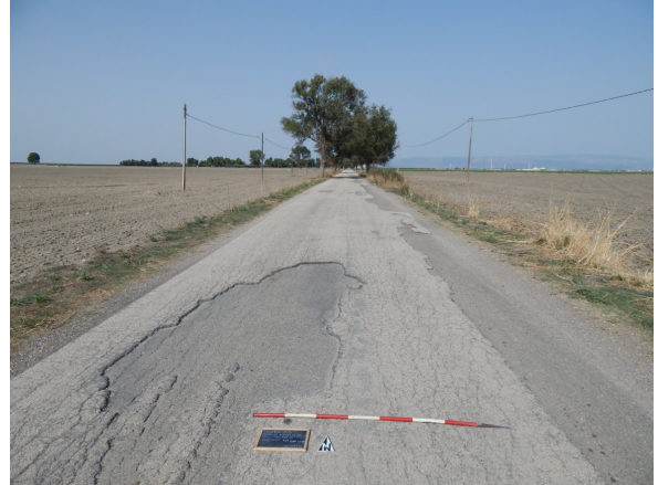
DSCN_5827 (UR 6 - Cavidotto km 4.00 - 5.00)
