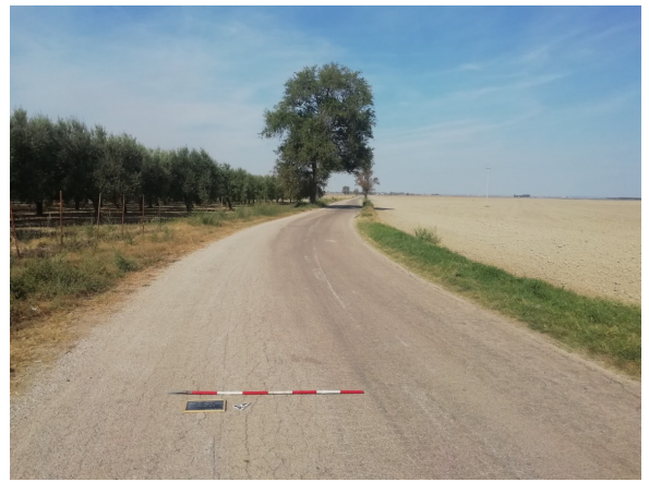
IMG_20211002_112955 (UR 8 - Cavidotto km 6.00 - 7.00)
