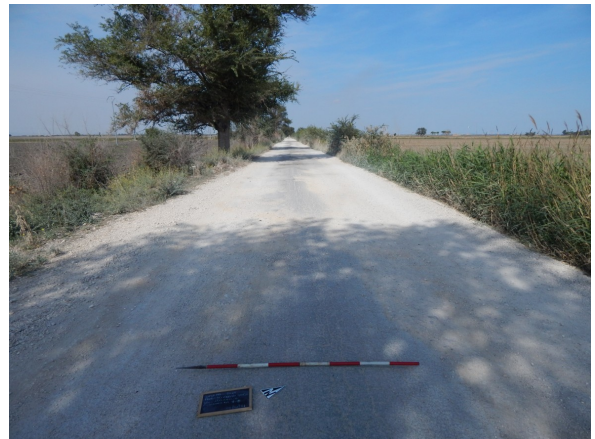
DSCN_5835 (UR 10 - Cavidotto km 8.00 - 9.00)
