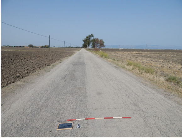
DSCN_5826 (UR 5 - Cavidotto km 3.00 - 4.00)
