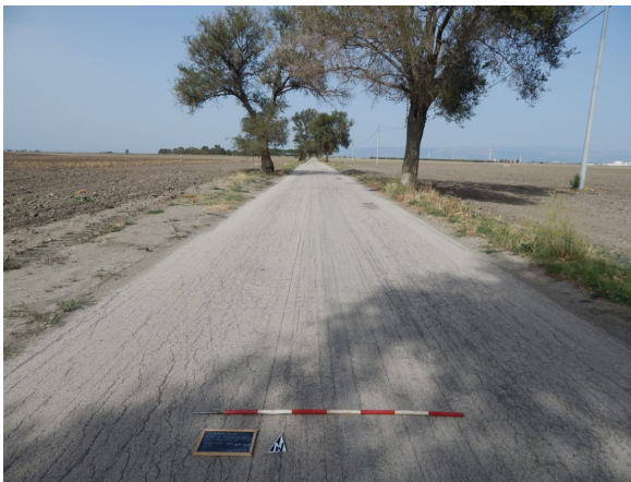
DSCN_5831 (UR 7 - Cavidotto km 5.00 - 6.00)
