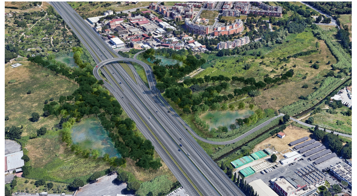
zona Pratolungo post operam
