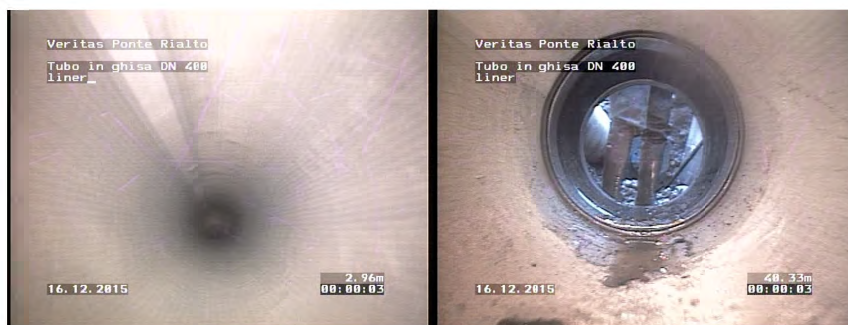
Tubazione dopo il risanamento
