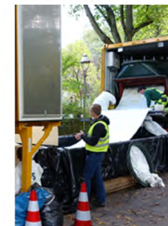
Inserimento liner nel tamburo
