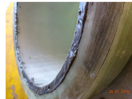
Sigillatura testa giunto con flange
