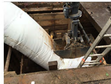
Inserimento liner nel pozzetto
