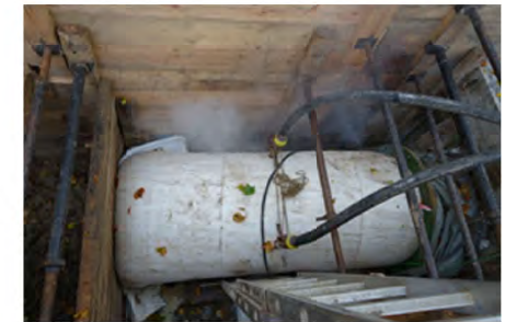
Parte terminale del liner
