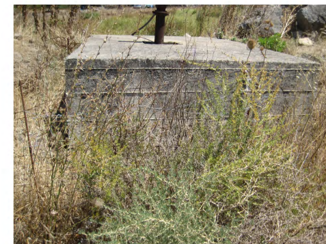
Demolizione blocchi di ancoraggio
