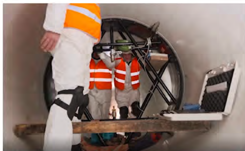
Esecuzione prove di tenuta
