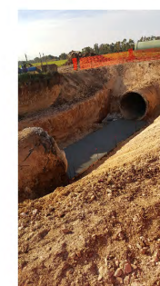
Scavo e apertura condotta
