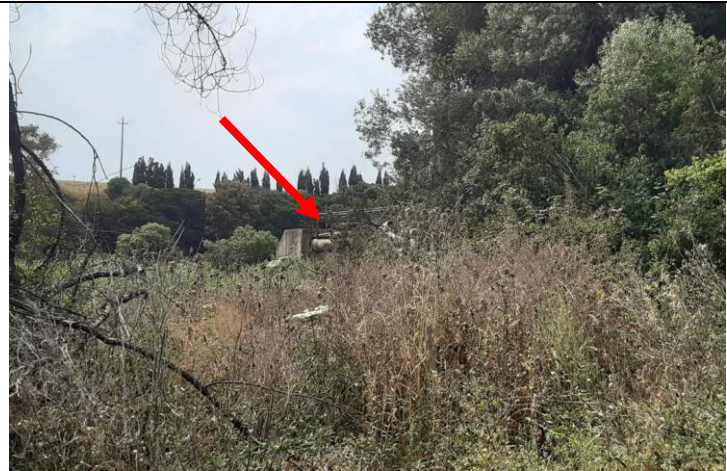
Figura 23 – Attraversamento Rio Ottava per cui si prevede la sostituzione del tubo e il risanamento strutturale dell'opera (indicata con freccia rossa)
