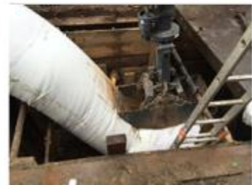
Inserimento liner nel pozzetto
