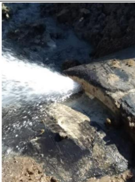
Figura 1 - Perdita tipo da giunto
