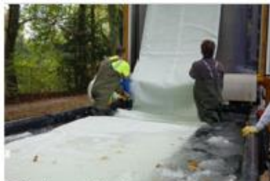
Raffreddamento liner in vasca d'acqua
