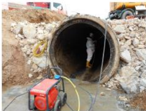
Pulizia della condotta
