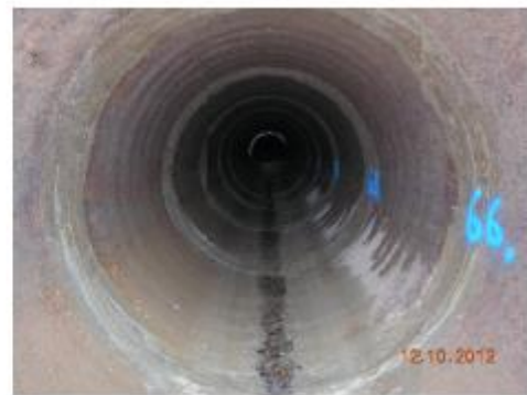
Condotta prima del risanamento
