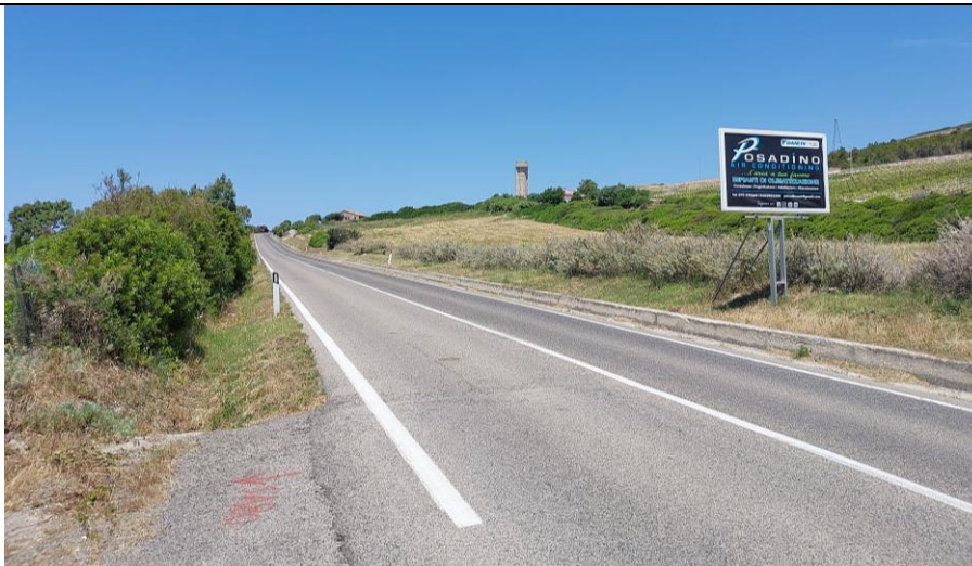
Figura 9 – Torrino piezometrico oggetto di demolizione
