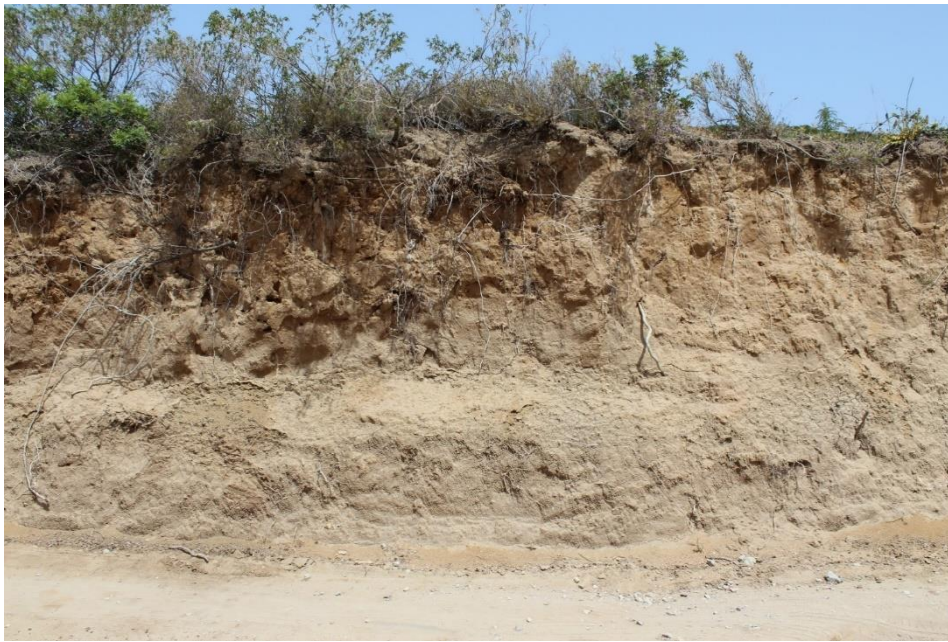
Figura 2.25 – Sabbie rossastre debolmente cementate in affioramento lungo il tratto di scavo in trincea della strada comunale che interseca la parte terminale del tratto di Condotta in relining Coghinas I.
