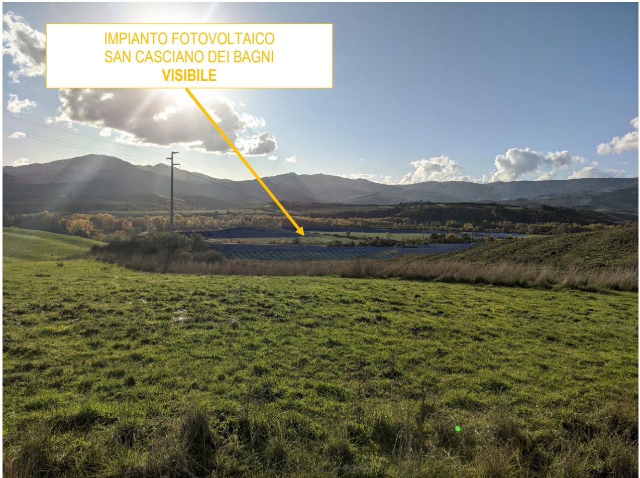
Foto 28: Visuale 17 – Impianto Fotovoltaico
