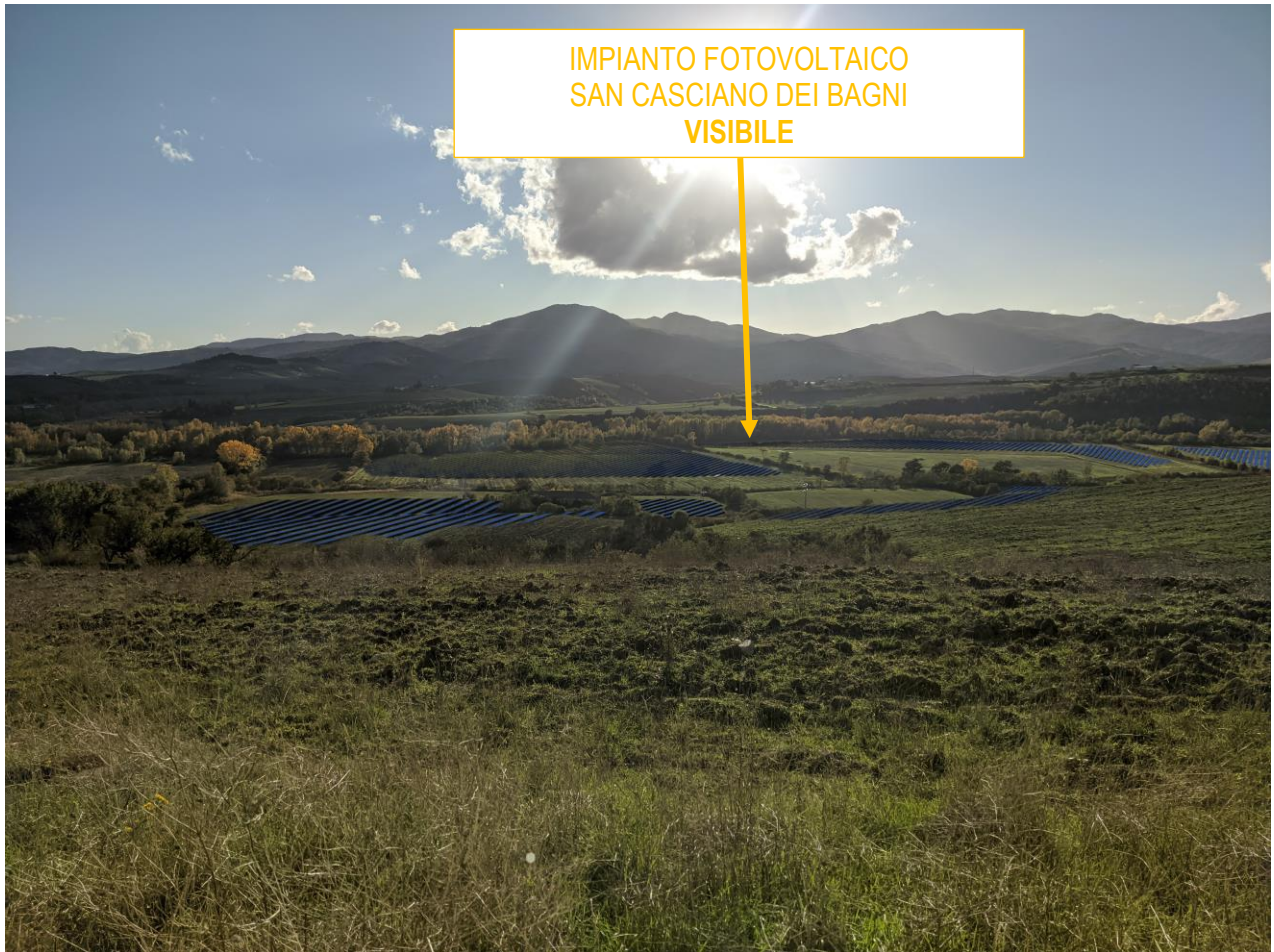
Foto 26: Visuale 16 – Impianto Fotovoltaico
