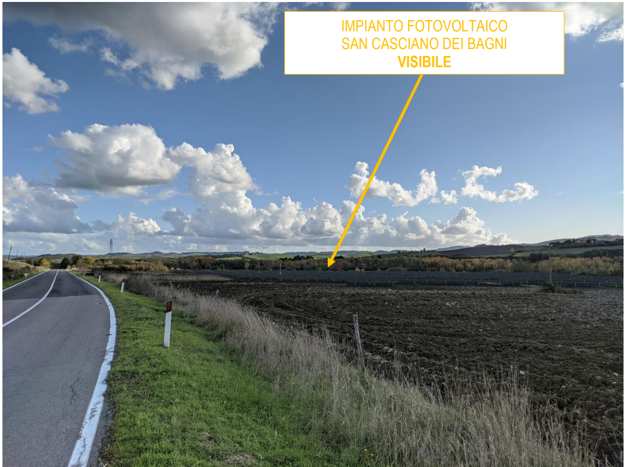
Foto 21: Visuale 13 – Impianto Fotovoltaico
