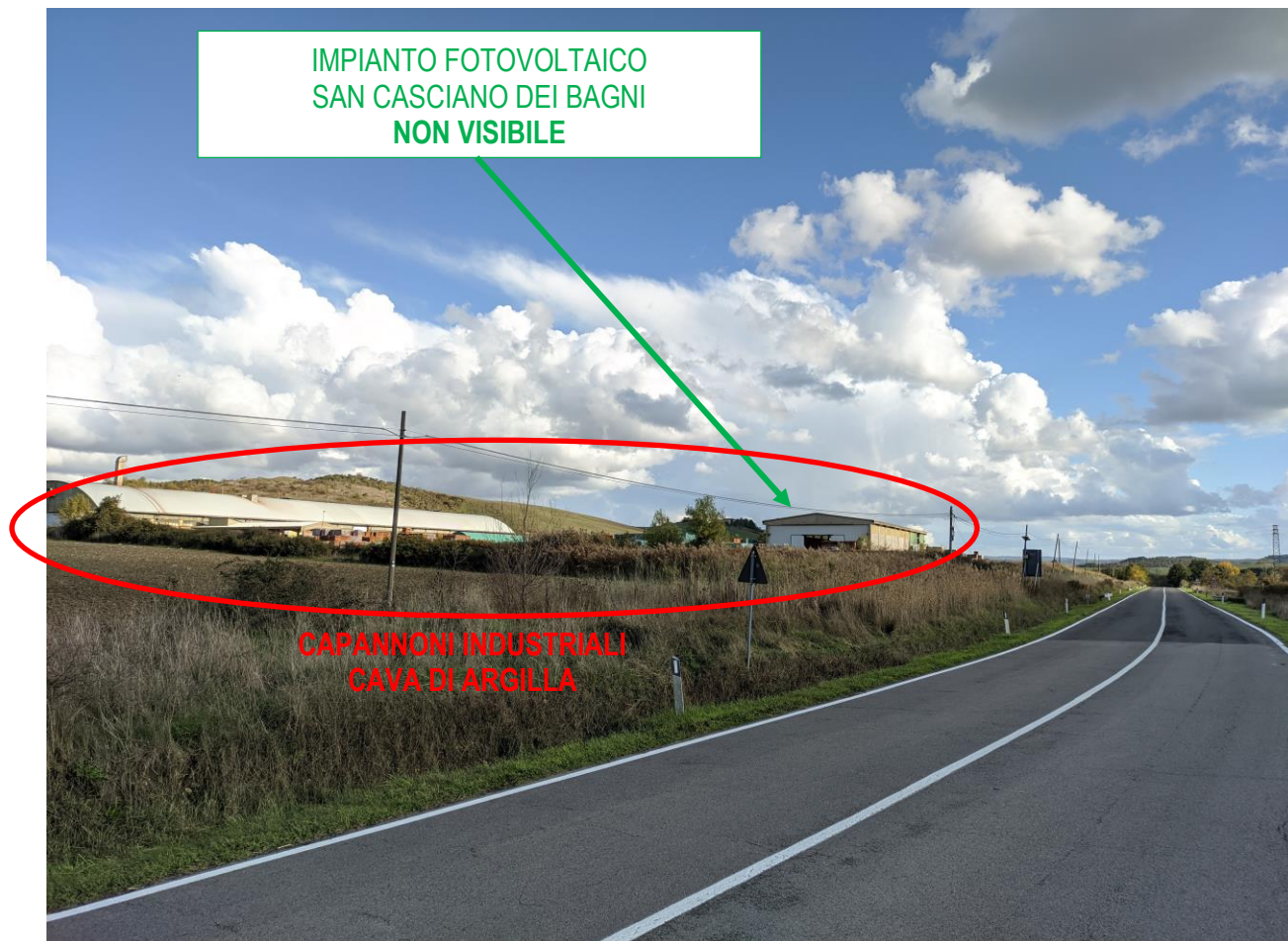
Foto 23: Visuale 14 – Stato dei Luoghi
