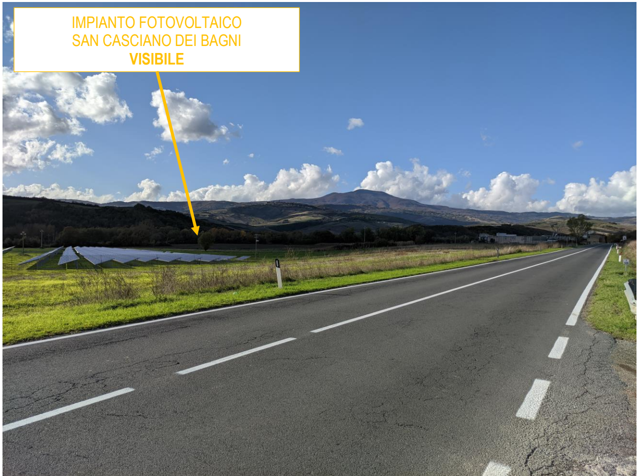
Foto 19: Visuale 12 – Impianto Fotovoltaico
