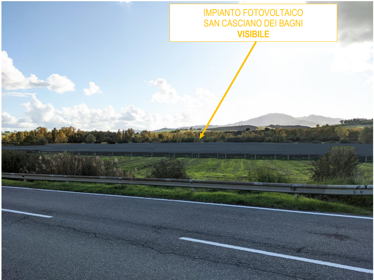
Foto 8: Visuale 6 – Impianto Fotovoltaico
