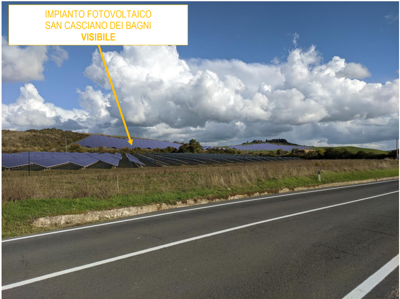
Foto 13: Visuale 9 – Impianto Fotovoltaico
