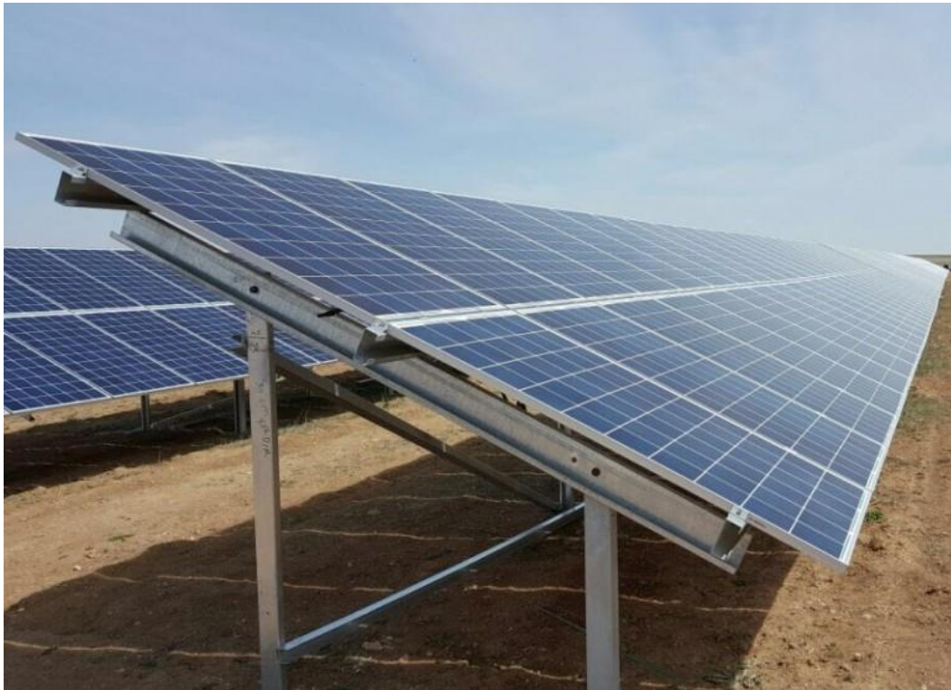
Figura 33: Esempio di Struttura Fissa
