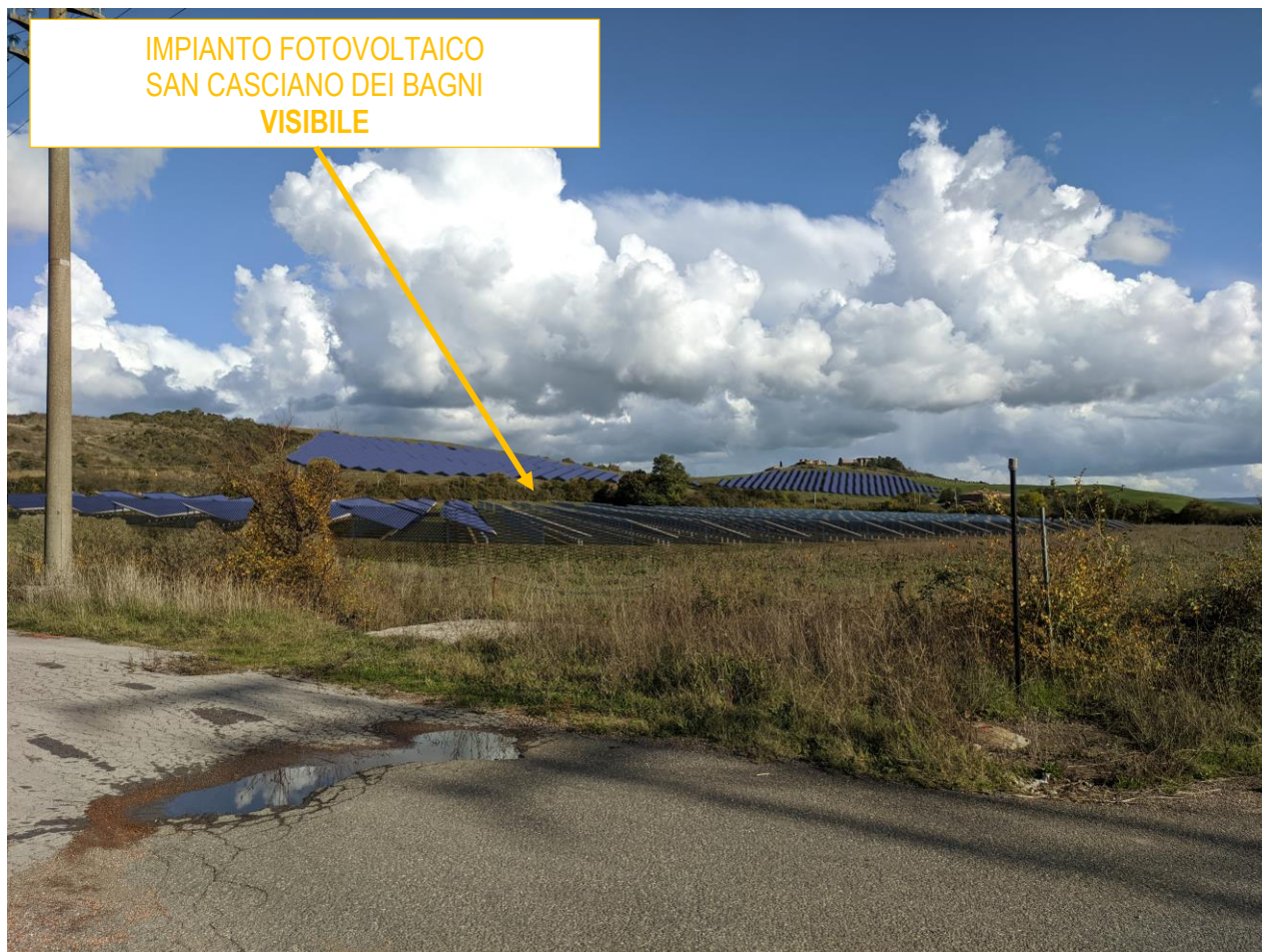
Foto 17: Visuale 11 – Impianto Fotovoltaico
