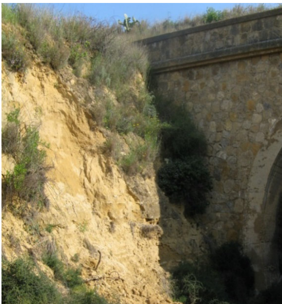
Figura 16: Trasporto di materiale sulla sede e caduta massi
