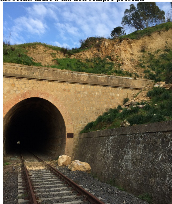
Figura 16: Trasporto di materiale sulla sede e caduta massi
