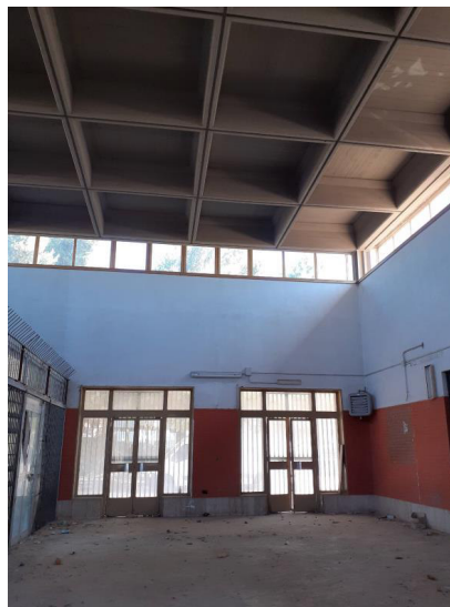
Figura 10a – Fabbricato viaggiatori, locale atrio
