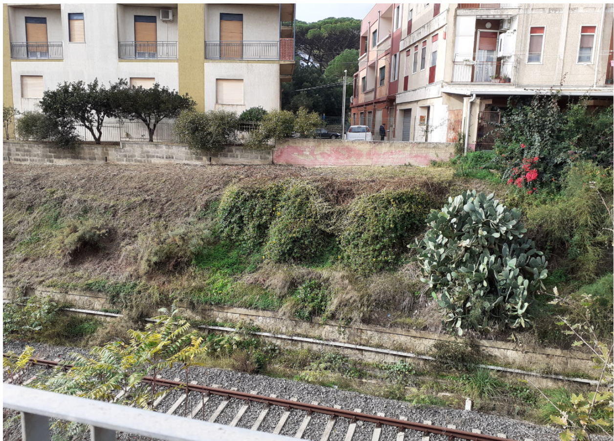
Figura 2.8 Trincee con fabbricati a tergo delle stesse
