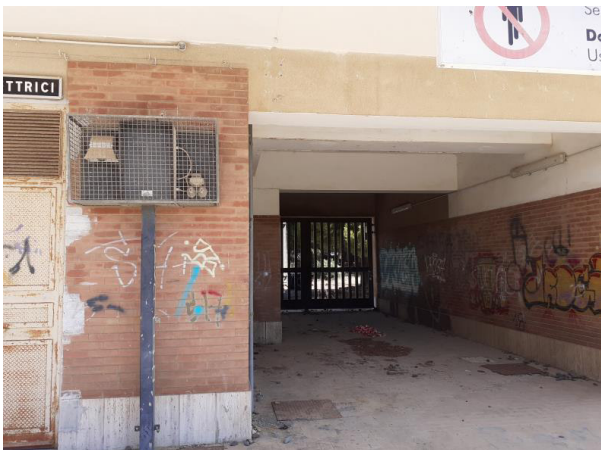
Figura 8 – Fabbricato viaggiatori portico ingresso
