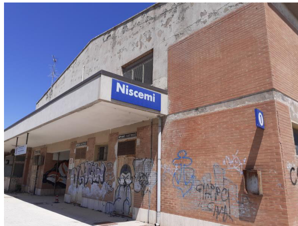
Figura 7 – Fabbricato viaggiatori, lato binari
