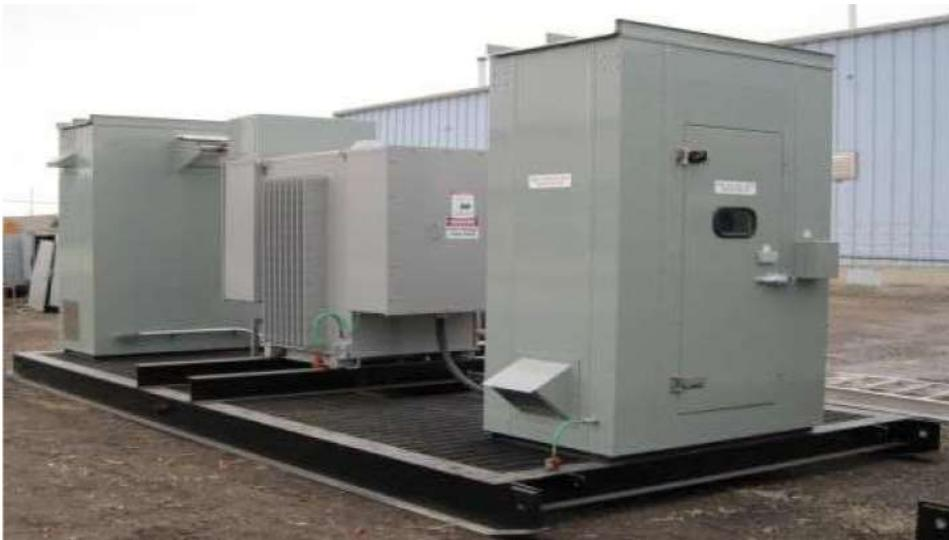
*Fig.3 base portante in carpenteria metallica zincata a caldo impermeabilizzata*
