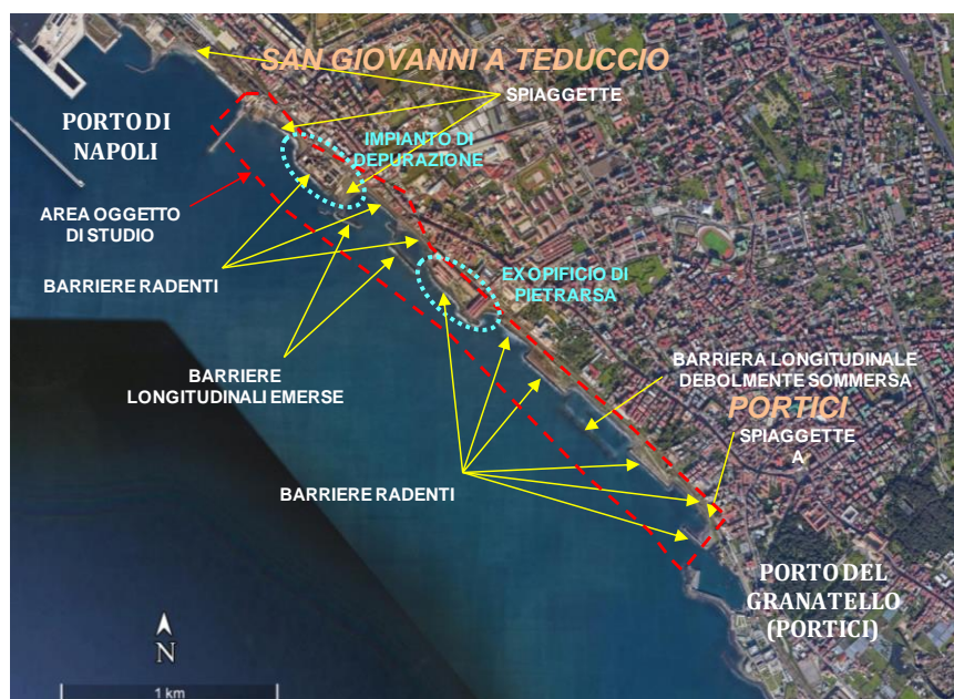
Figura 19 - Vista d'insieme del tratto di litorale oggetto di studio, margine sud-orientale del comune di Napoli (quartiere di San Giovanni a Teduccio), ricompreso per gli aspetti geomorfologici nell' U. F. di Torre del Greco
