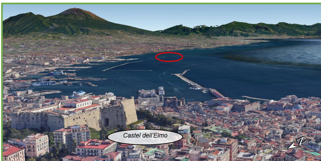
Figura 5-42 Vista a volo d'uccello da Castel dell'Elmo verso l'area di interventi (nel cerchio rosso)
