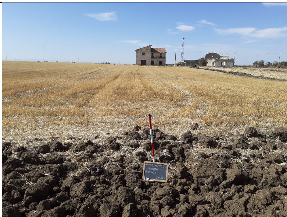
Foto 2: area dell'impianto fotovoltaico, panoramica, vista da E.
