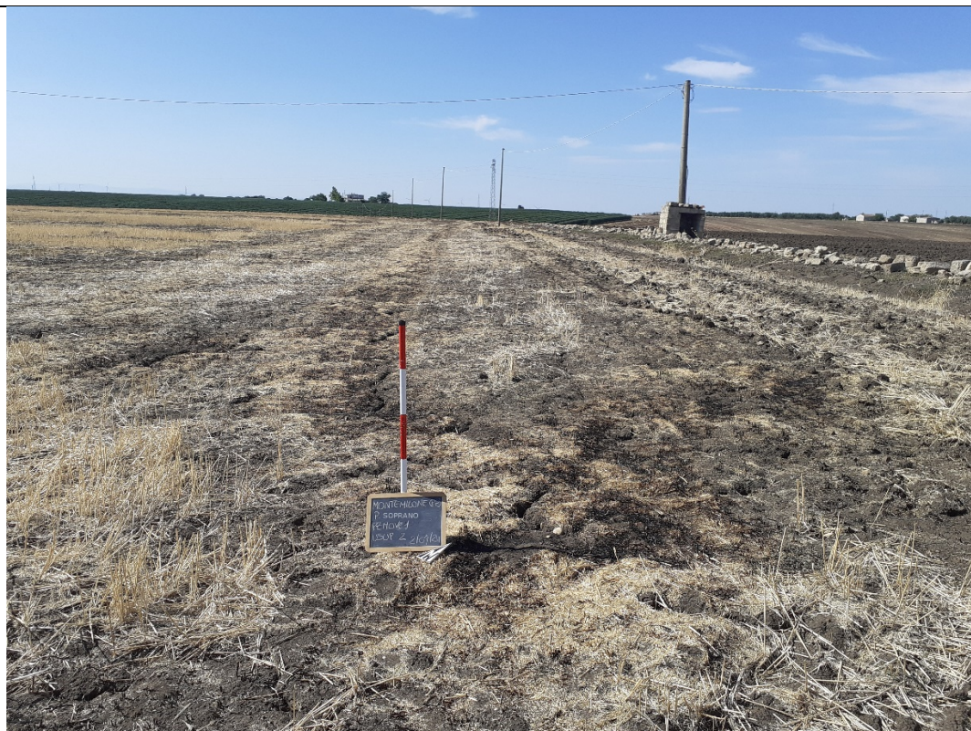
Foto 5: cavidotto interno, secondo tratto, vista da E
