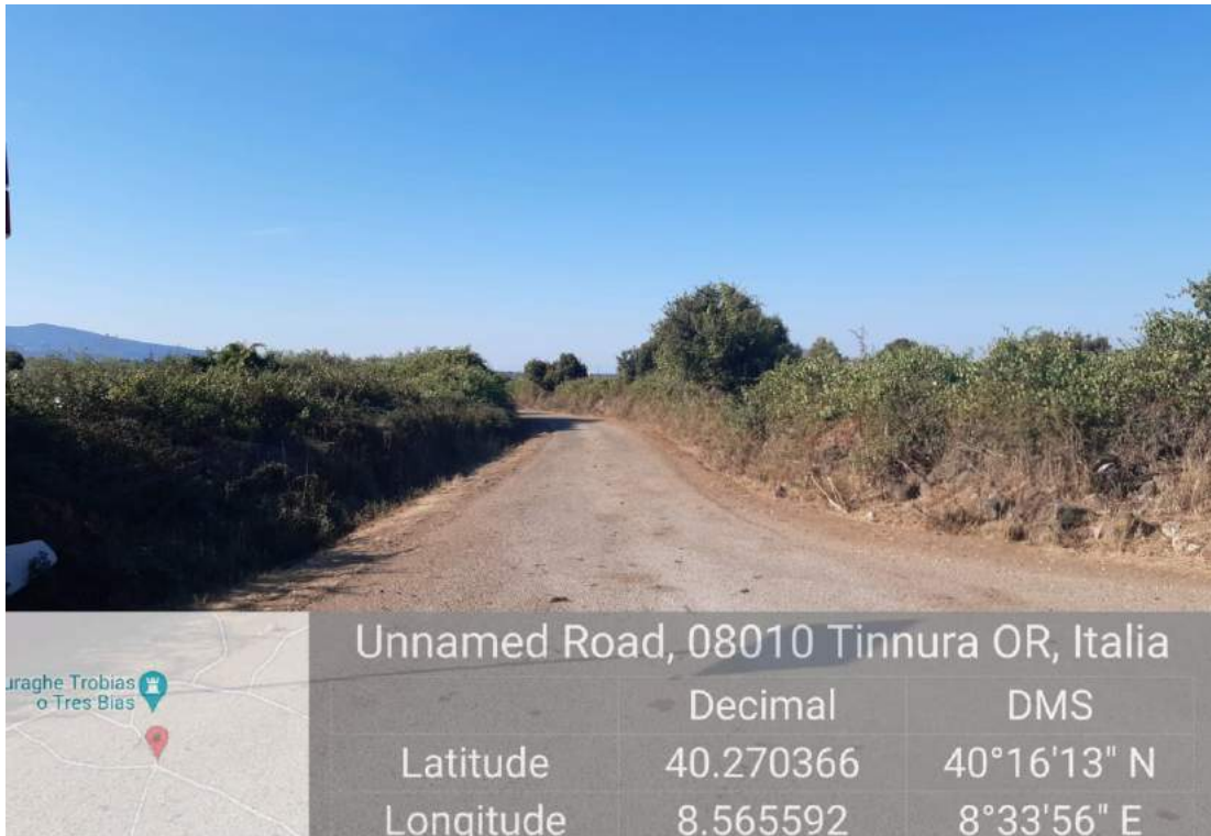
Tinnura: strada interessata dal tracciato del cavidotto.
