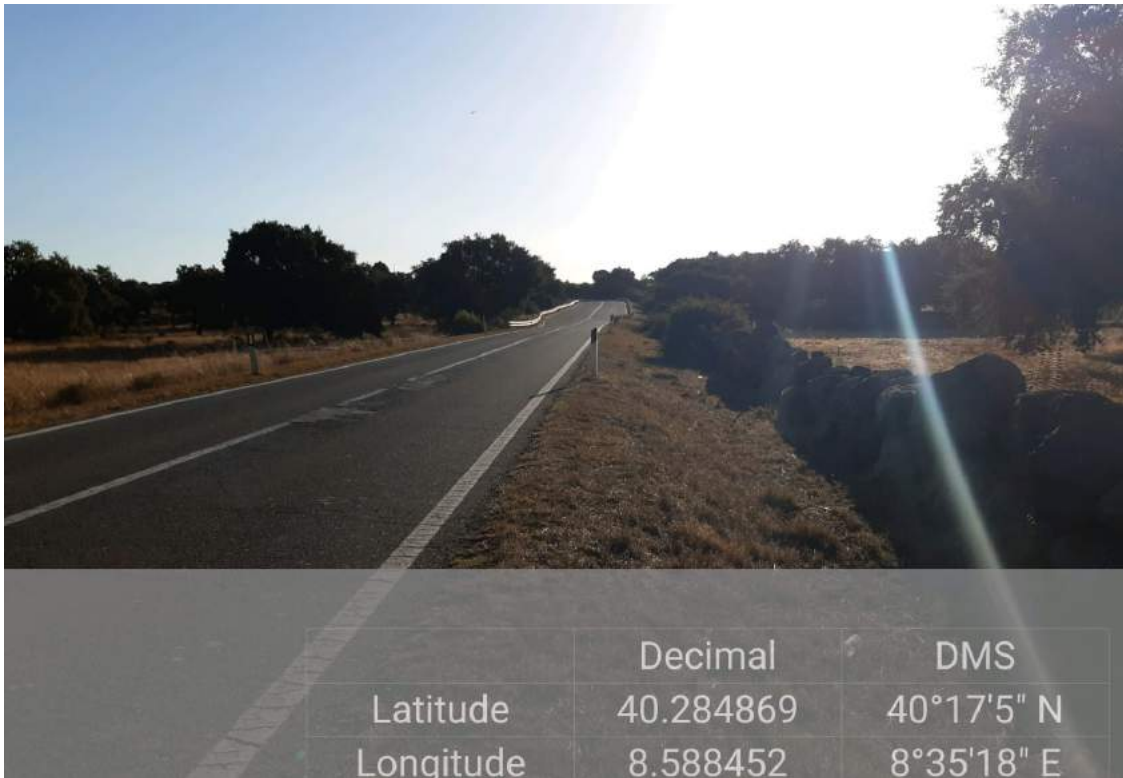
Suni, Strada Statale 129bis: tratto stradale interessato dal tracciato del cavidotto.
