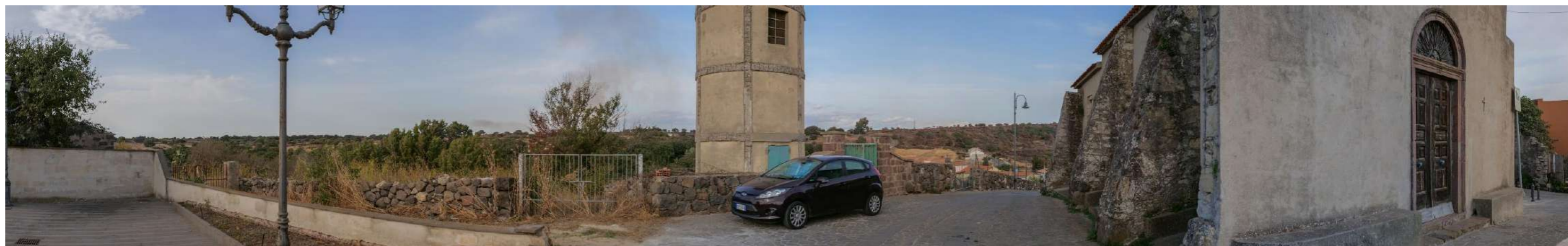
FOTO – STATO DI FATTO
