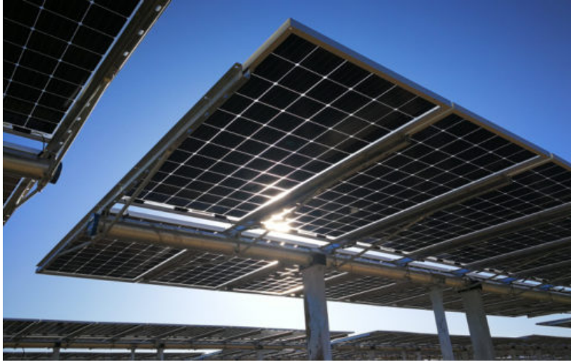
Figura 3.2: Esempio di struttura a tracker monoassiale
