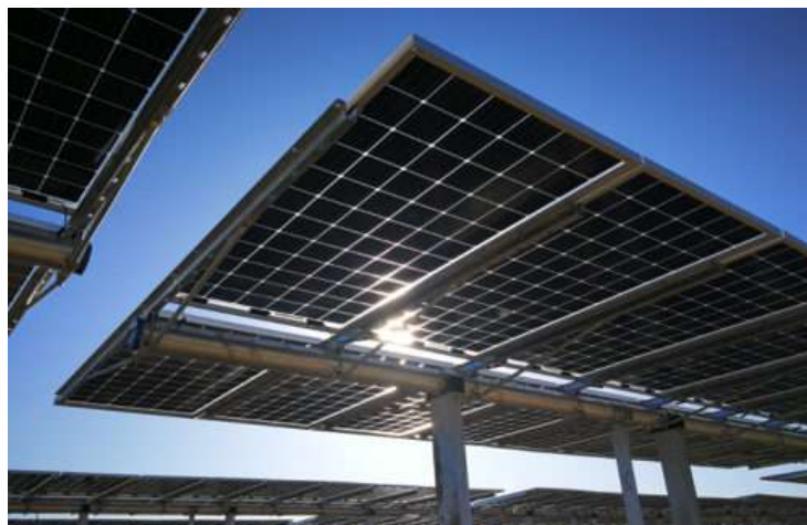
Figura 2.37: Esempio di struttura tipo tracker monoassiale
