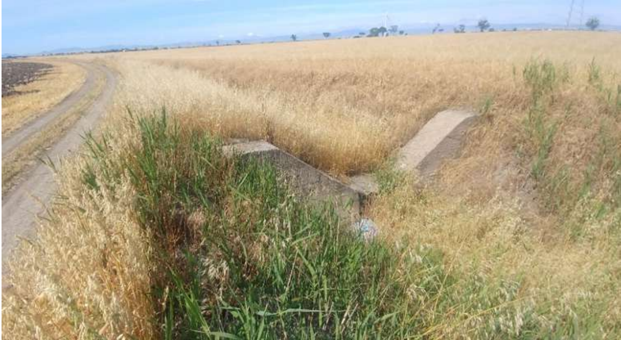
Figura 4.22: Zona di attraversamento del torrente Laccio
