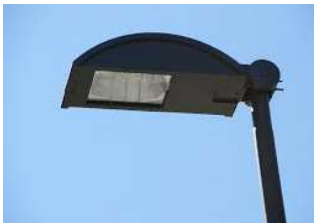
Figura 4.34: Esempio di apparecchio completamente schermato (full-cut-off).
