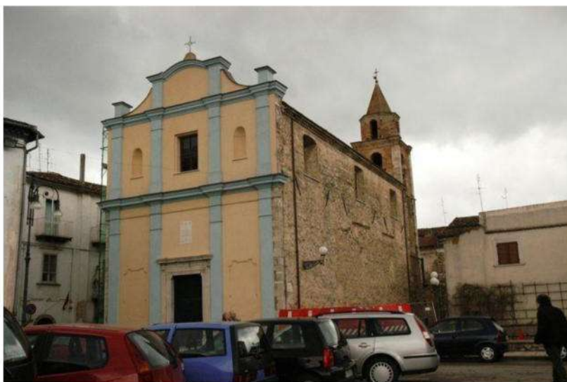
Figura 24 – Facciata ad ovest e facciata principale della chiesa
