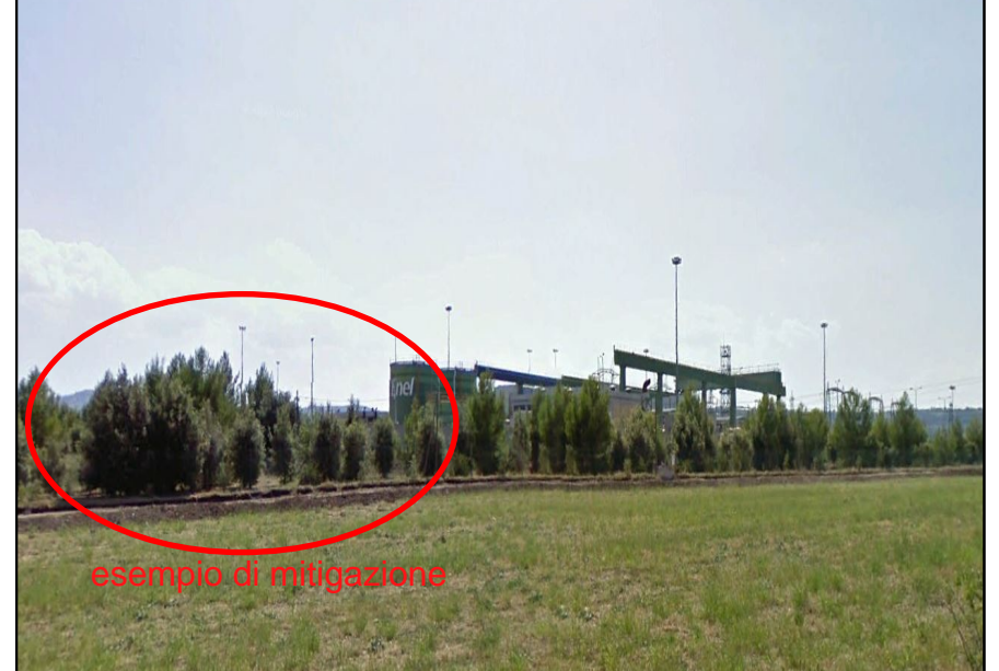
DETTAGLIO CENTRALE TURBOGAS ENEL
