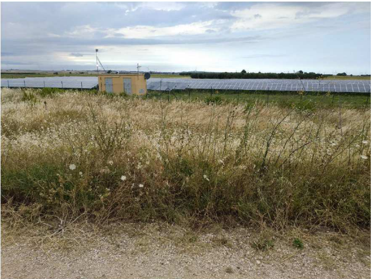
Stazione di Elevazione Foto 38
