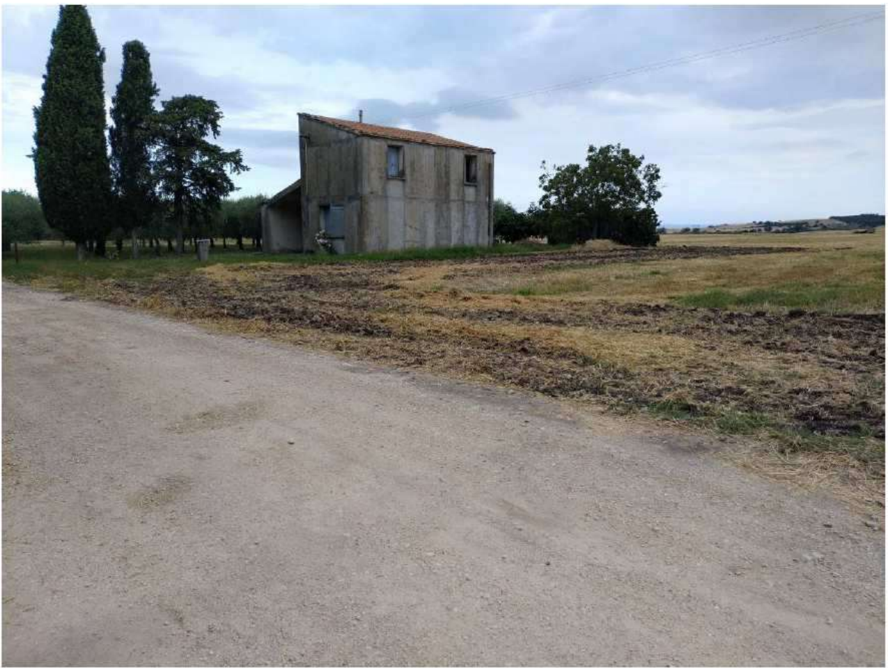
Stazione di Elevazione Foto 49
