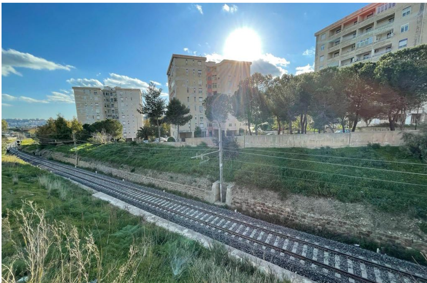
6. Vista dell'area d'intervento da Via Unità d'Italia
