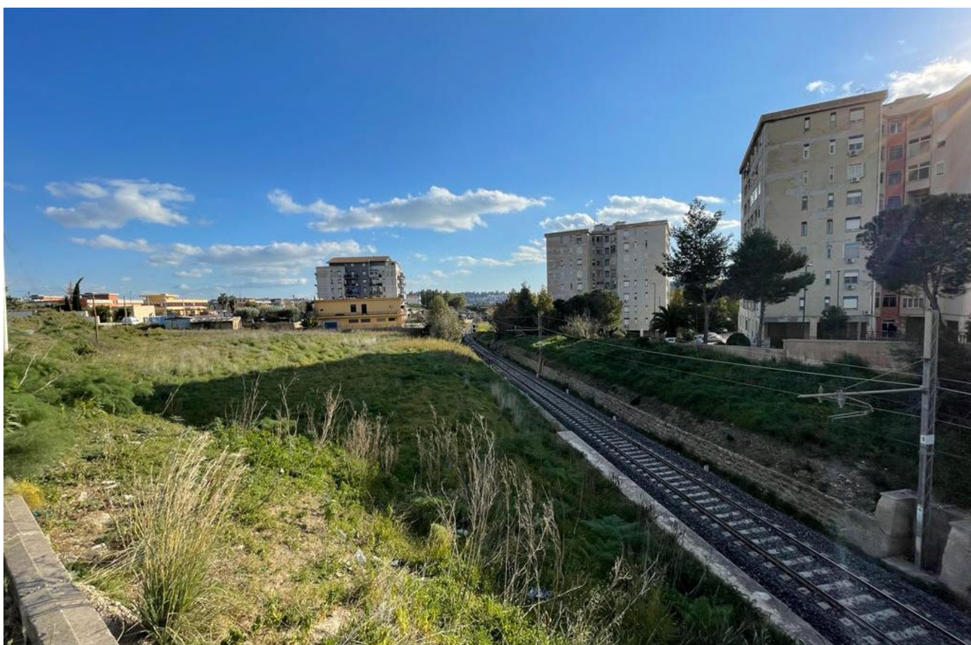
5. Vista dell'area d'intervento da Via Unità d'Italia
