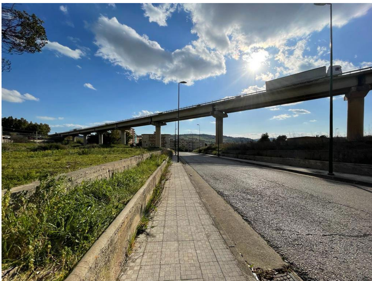
2. Vista dell'area d'intervento (a sinistra) da via Vittorio Savatteri Castelli
