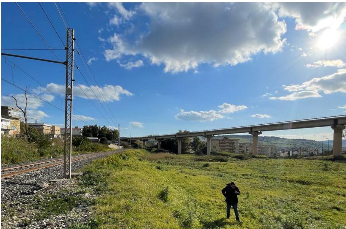
8. Vista dall'area d'intervento verso viadotto Fontanelle (SS 189)
