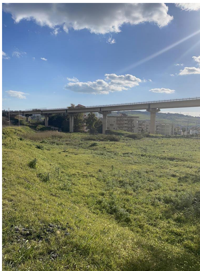
10. Vista dall'area d'intervento verso viadotto Fontanelle (SS 189)
