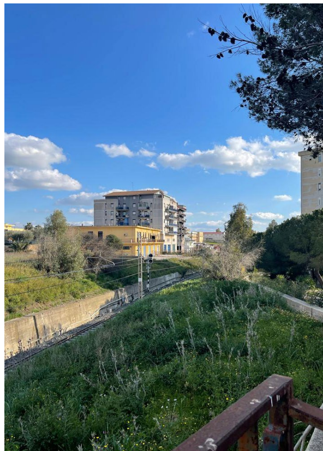
4. Vista dell'area d'intervento da Via Unità d'Italia
