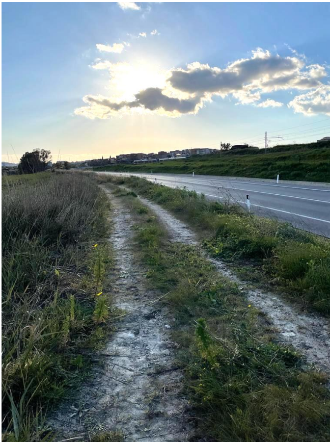
10. Selezione fotografica - accesso all'area oggetto d'intervento - panoramica Sito nuova Fermata di San Michele
