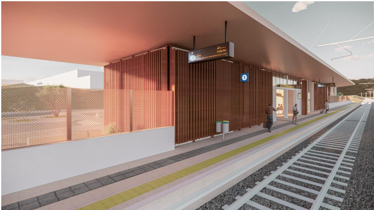
23. Vista lamelle e copertura in alluminio "effetto corten" banchina nuova fermata di San Michele
