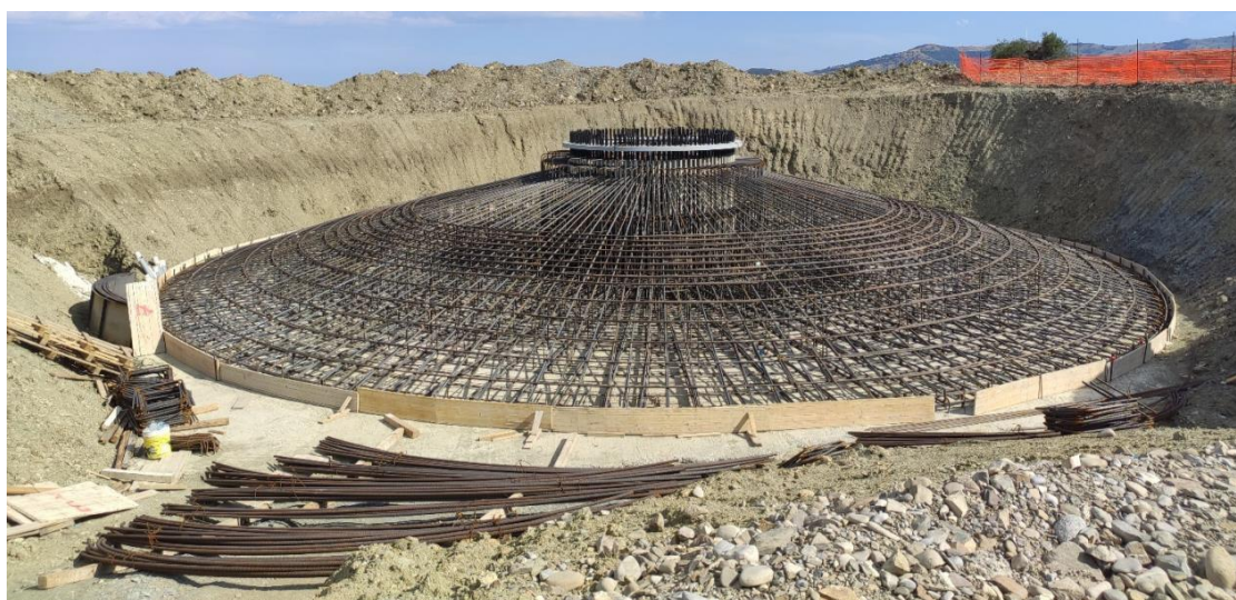
Figura 4: armatura plinto tipo
