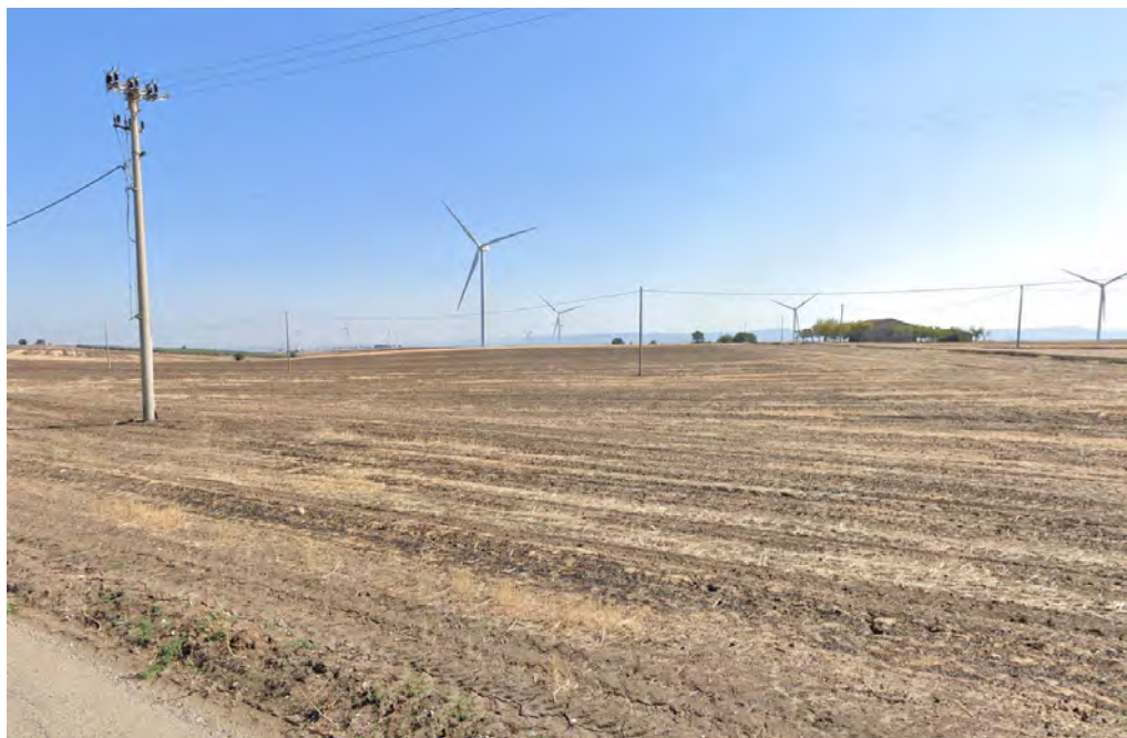
Foto dalla viabilità della SP78 – vista degli impianti eolici già realizzati
