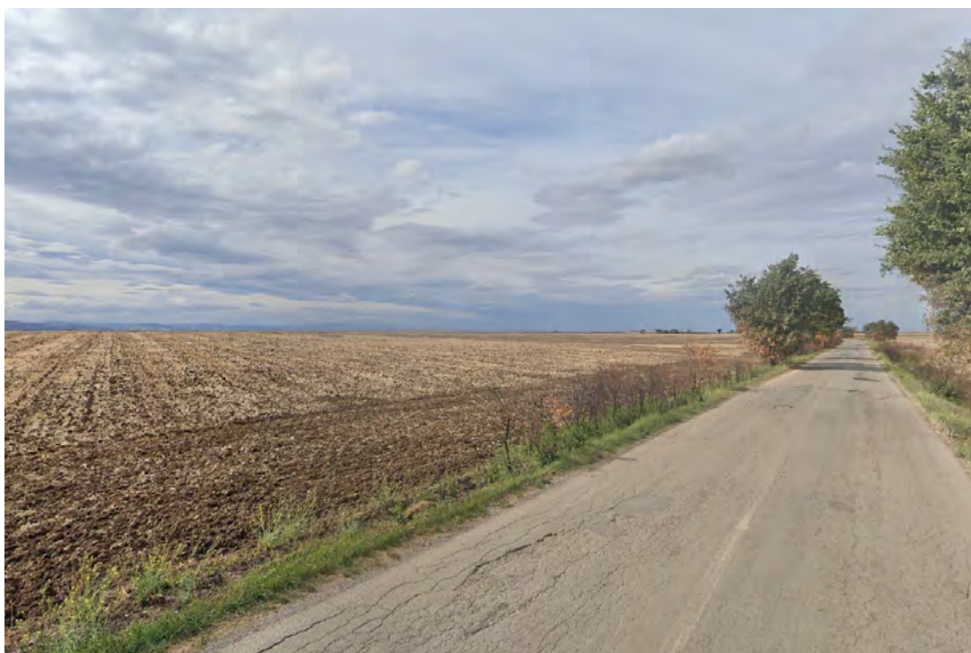
Foto della viabilità locale interessata dal caviodotto MT
