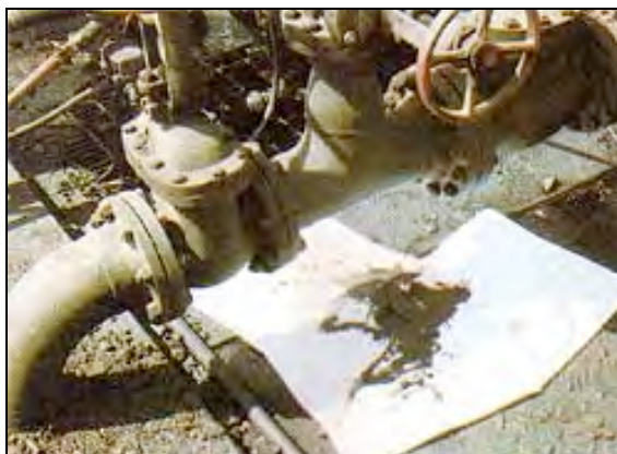
Uso di fogli oleoassorbenti per contenere lo sversamento al suolo di oli minerali
