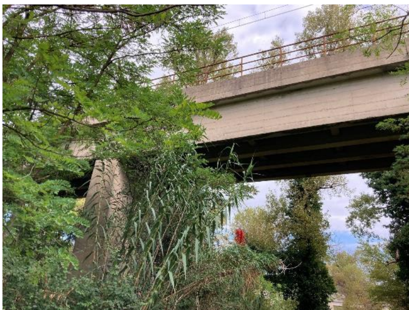
Figura 9 - Il viadotto ferroviario esistente VI02a sul torrente Settimo
