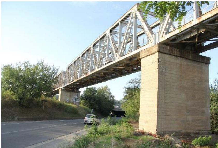
Figura 1 - Il viadotto ferroviario esistente VI01a di scavalco dell'autostrada A3
