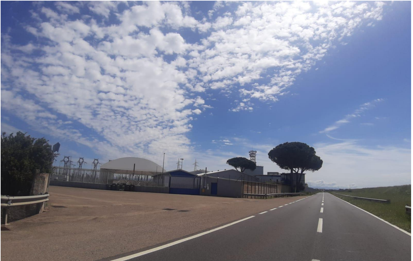
Foto 16: sopralluogo UR 7 - aprile 2021.
