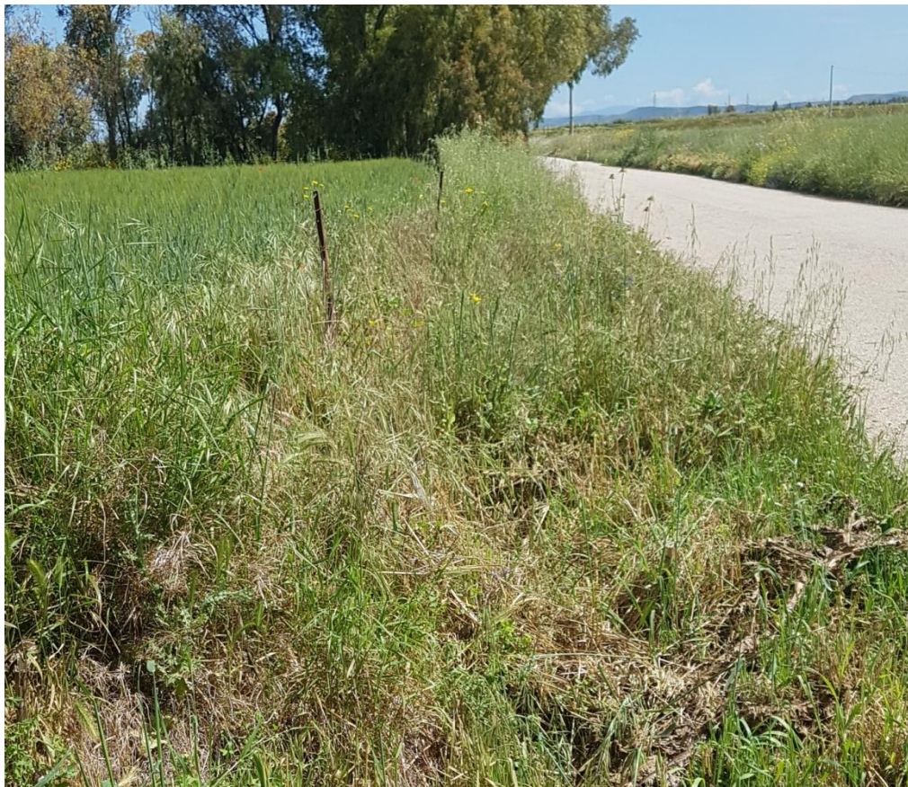
Foto 6: sopralluogo UR 4 - marzo 2021.
