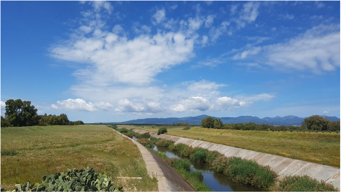
Foto 14: sopralluogo UR 6 - aprile 2021.
