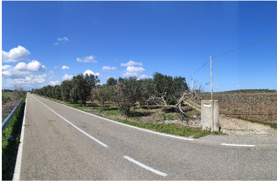
Figura 63: Stato ante operam dal POI15 (SP111)
