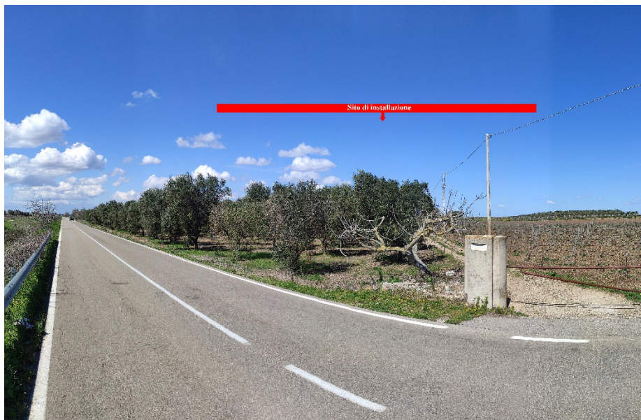
Figura 64: Stato post operam dal POI15 (SP111)
