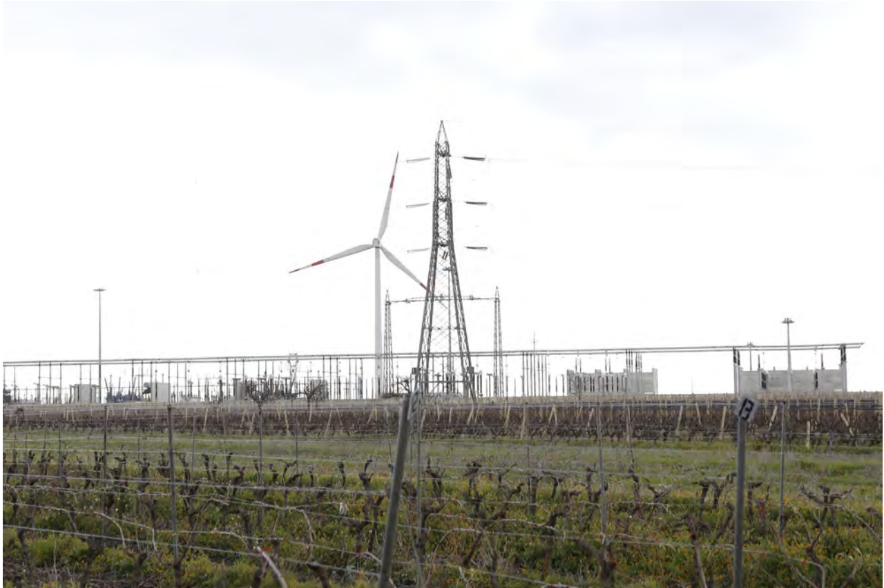
Figura – Sullo sfondo, la stazione elettrica già esistente all'interno del sito in esame (Foto Studio Rocco Carella).
