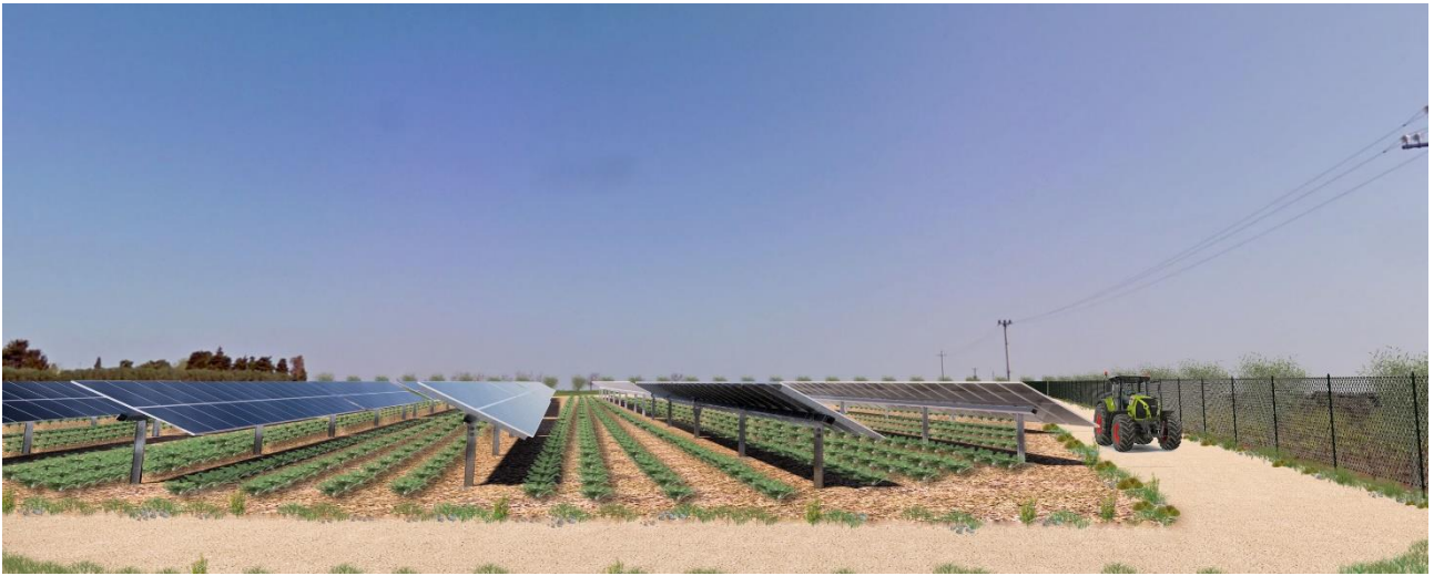
Figura 11: Fotoinserimento dell'area di progetto che mostra l'inserimento di colture autoctone tra le file dei tracker che costituiscono l'impianto
