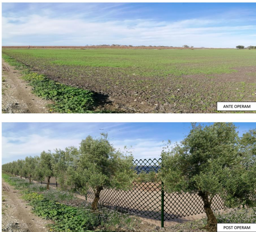
Figura 12: vista ante e post operam della fila di ulivi posta esternamente alla recinzione al fine di attenuare l'impatto visivo dei pannelli fotovoltaici
