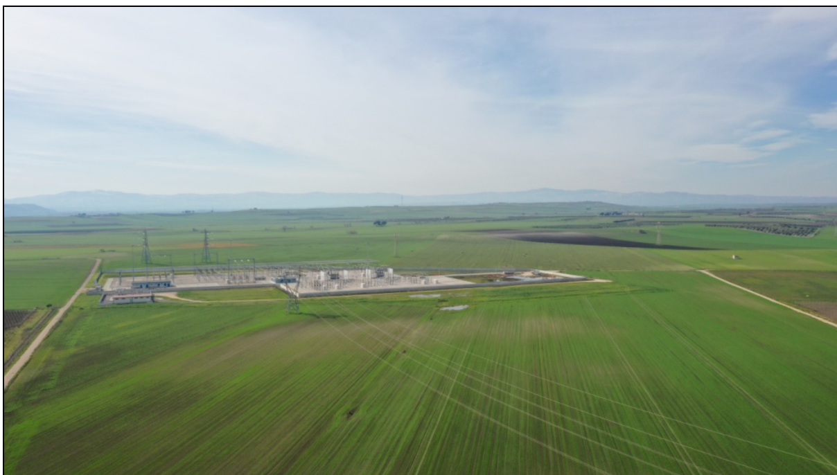
Figura 7 - Vista aerea della Stazione Elettrica Terna "San Severo".
