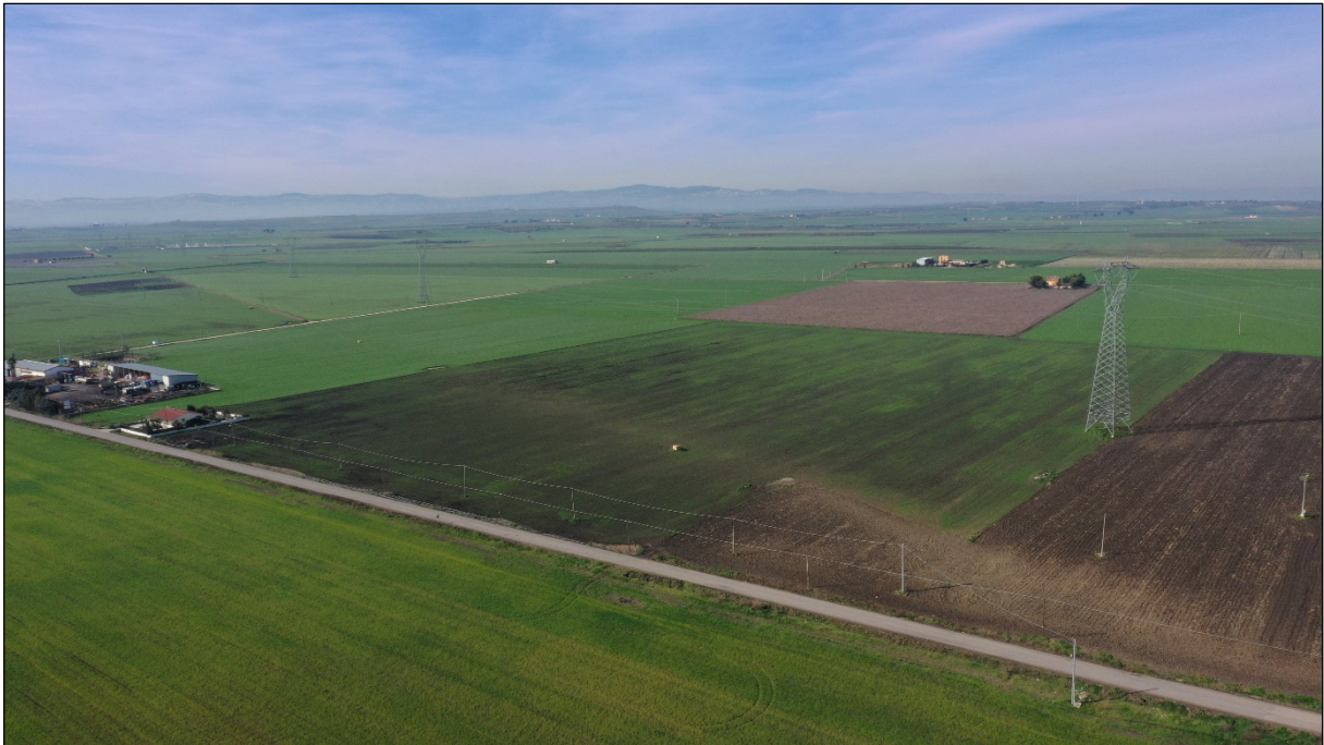
Figura 7 - Vista aerea da EST dell'area d'impianto.
