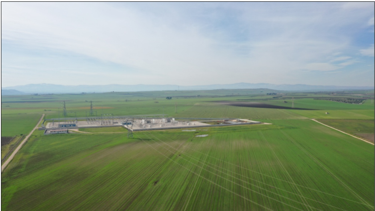
Figura 8 - Vista aerea della Stazione Elettrica Terna "San Severo".
