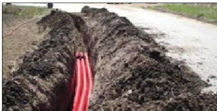
*Figura 19 - Tipologico scavo per cavidotto MT.*
