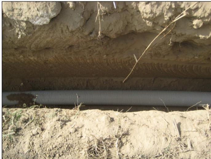
*Figura 20 - Tipologico scavo per cavidotto MT.*
