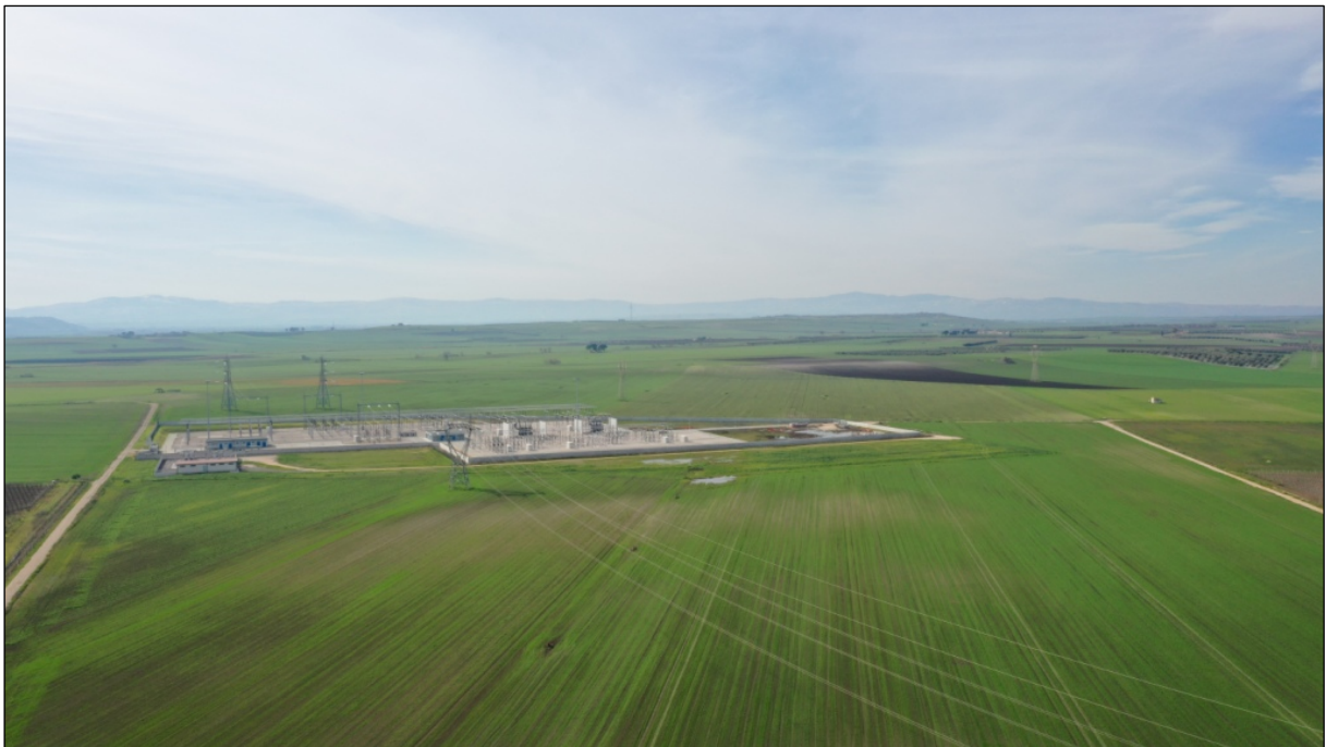
Figura 8 - Vista aerea della Stazione Elettrica Terna "San Severo".
