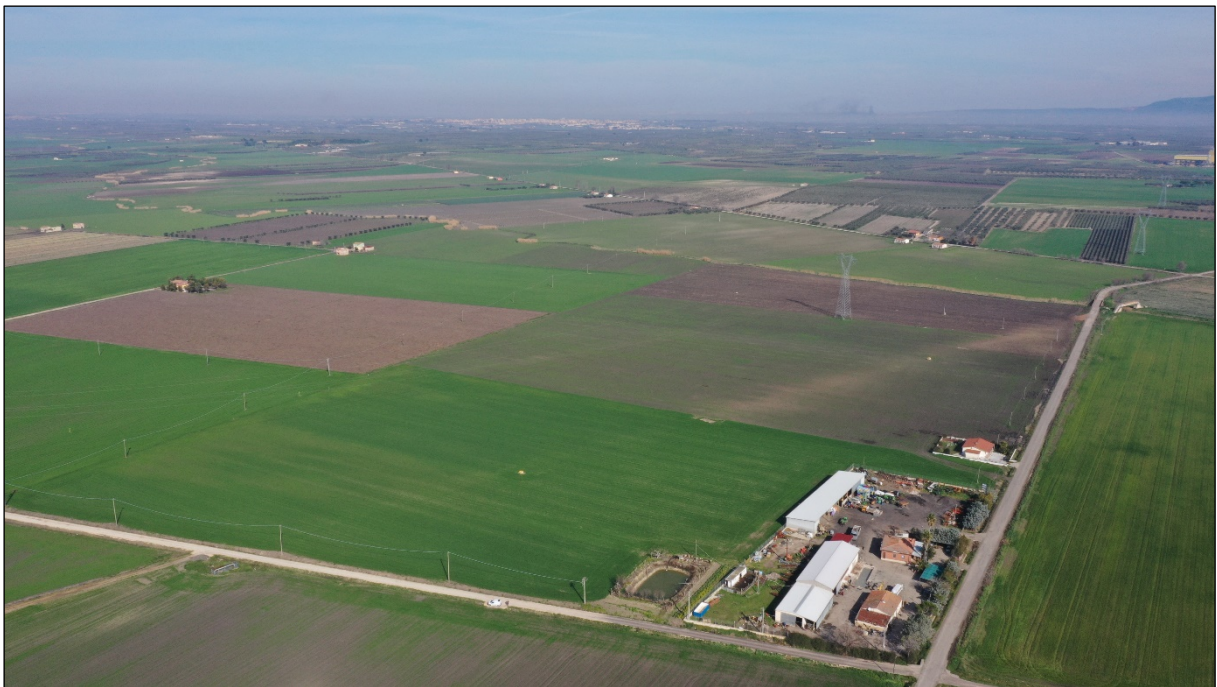
Figura 6 - Vista area da SUD dell'area d'impianto.
