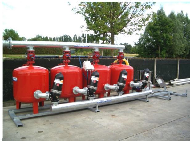
Figure 21 e 22 – a sinistra, una elettrovalvola in ghisa del tipo ad installarsi sulle condotte secondarie a servizio dei diversi settori irrigui; a destra, stazione di filtrazione con filtri a graniglia ed a rete in parallelo.
