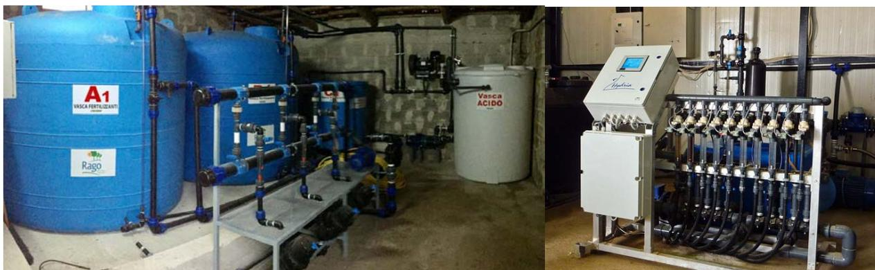
Figure 23 e 24 – a sinistra, una batteria di vasche contenenti i fertilizzanti liquidi e l'acido; unità di gestione della fertirrigazione che accorpa strumentazione di monitoraggio, di controllo, e di iniezione.
