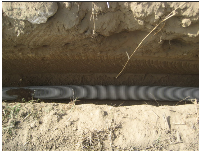
Figura 24 - Tipologico scavo per cavidotto MT.
