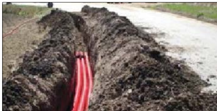
Figura 23 - Tipologico scavo per cavidotto MT.
