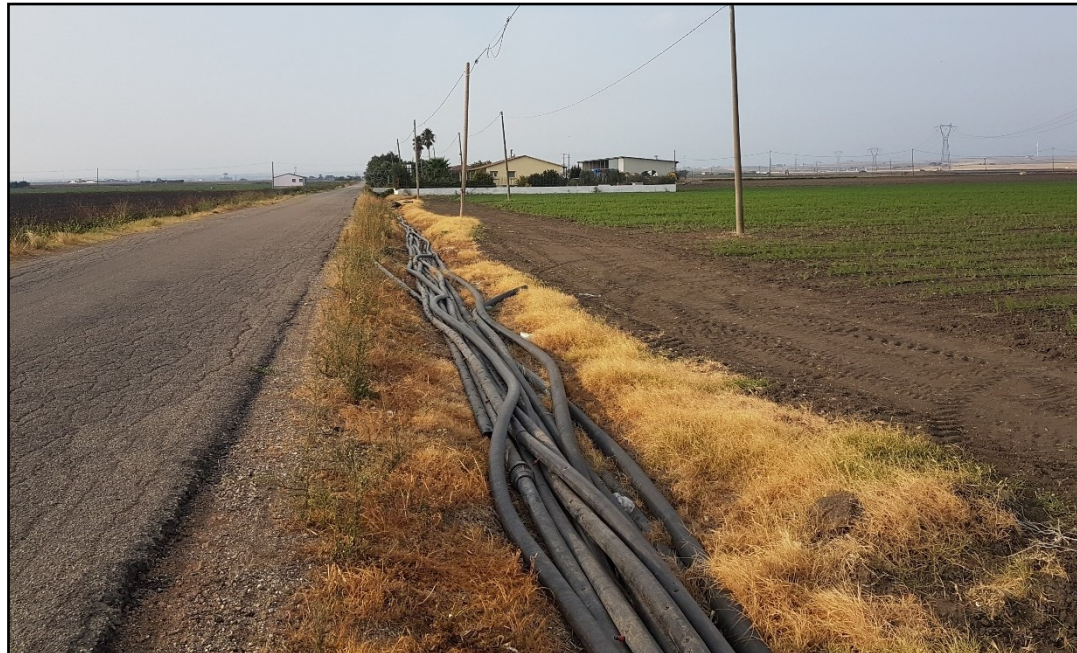
Fig.5.24 – Area d'intervento – Particolare del fosso di guardia occupato da tubi di impianti di irrigazione per coltivazione in campo aperto di ortaggi.
