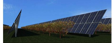
PROGETTO DI UN IMPIANTO DI ENERGIA ELETTRICA DA FONTE SOLARE FOTOVOLTAICA DELLA POTENZA NOMINALE DI 19,051 MWp DENOMINATO "RUSSI" INTEGRATO CON PIANTE DI MELOGRANO
