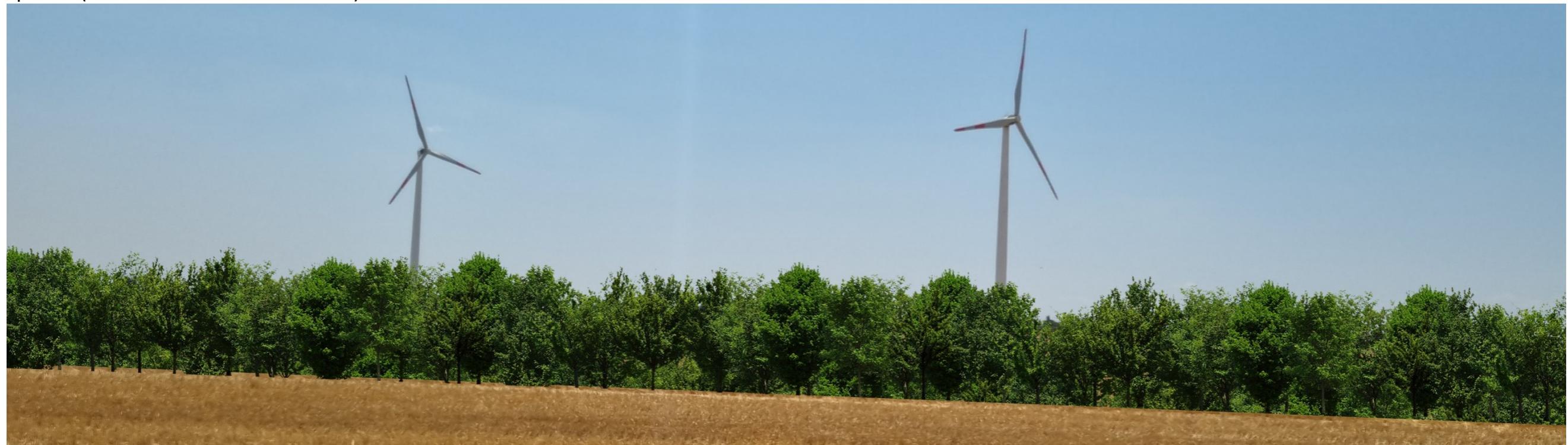
Post operam (vista da Q3 – Masseria Grieco)
