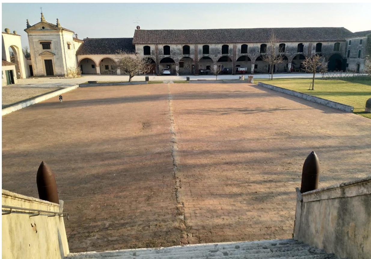
Figura 2 – Il lato sud della Corte Zera
